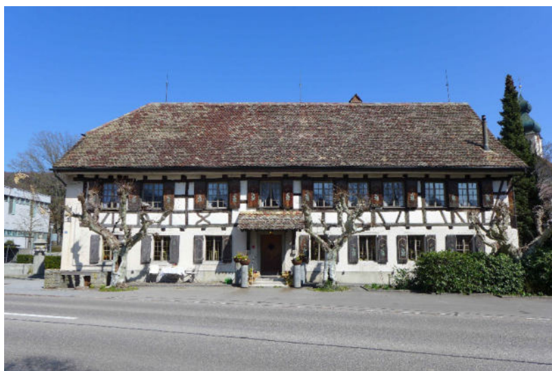
Strassenseitige Traufansicht von Südwesten (2019)
