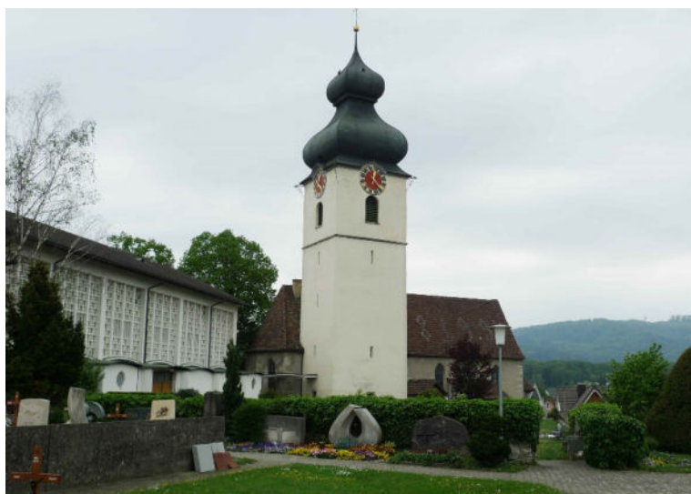
Ansicht von Nordosten (2019)
