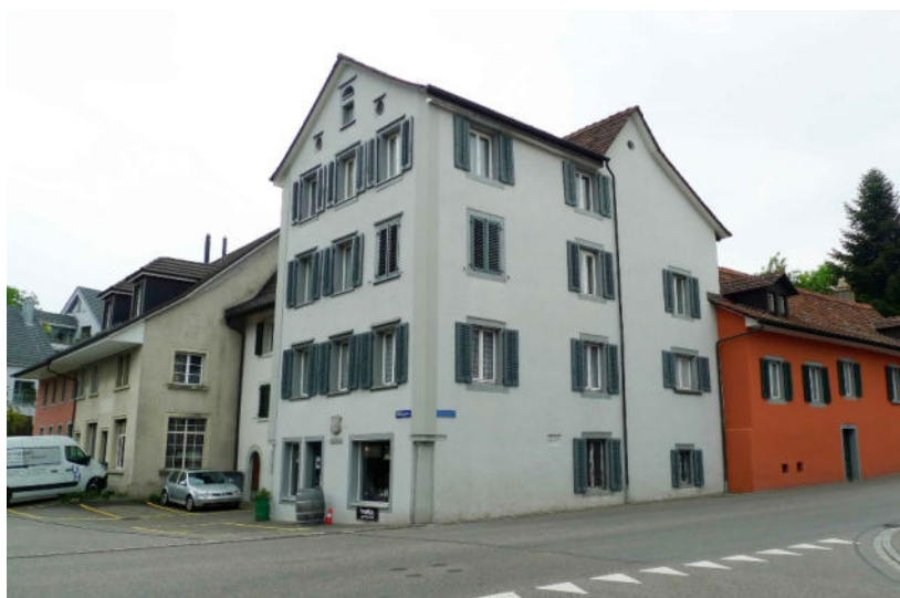
Ansicht Gebäudekomplex von Westen (2019)
