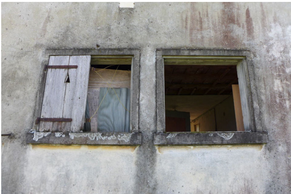
Fenster an der nördlichen Giebelseite des Wohnhauses (2023)
