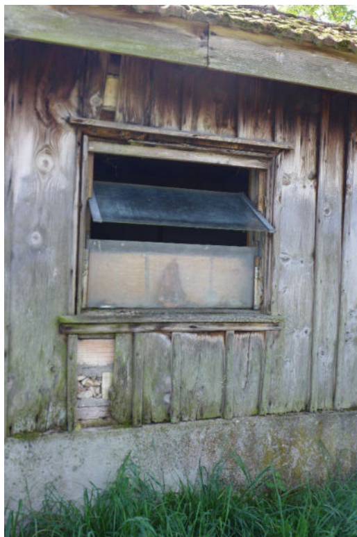
Stallfenster an der nördlichen Stallwand (2023)
