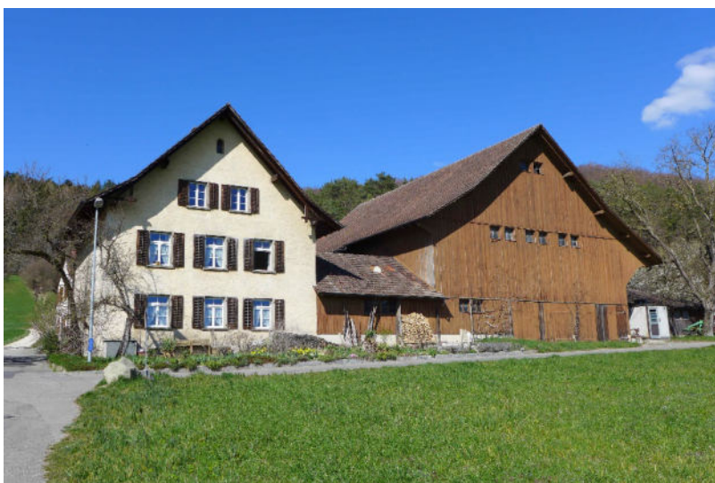
Ansicht Wohnhaus und Scheune von Süden (2019)
