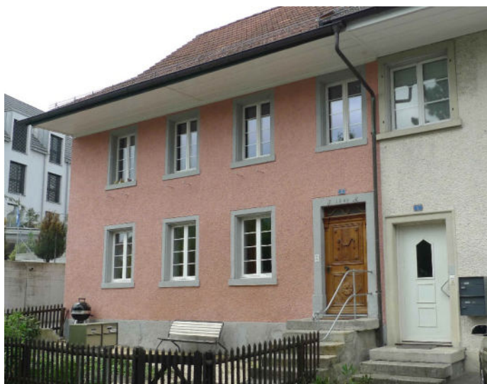
Strassenseitige Ansicht von Nordwesten (2020)
