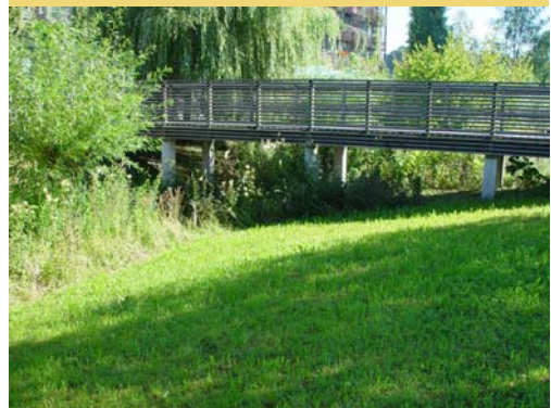
Beispiel eines Bachüberganges
