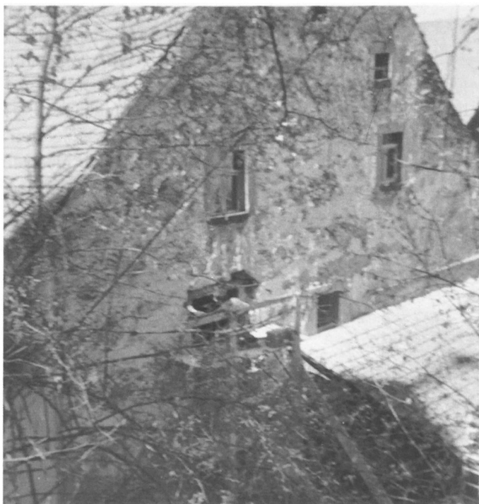
Nordfassade vor der Absenkung des Vorgeländes.
