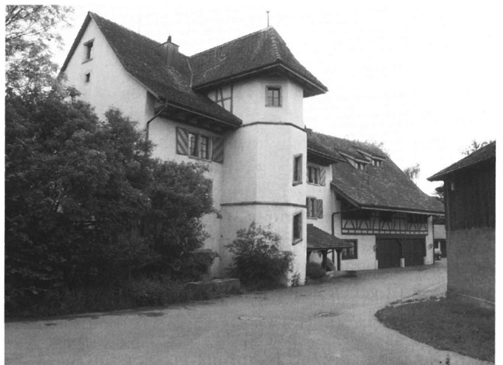
Mühle Oetlikon: Nordfront im heutigen Zustand.
