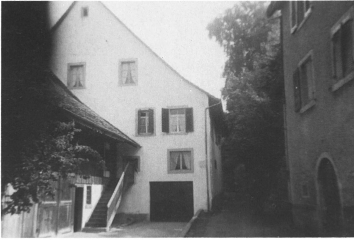
Die Eingangspartie an der Mühlegasse vor dem Umbau.
