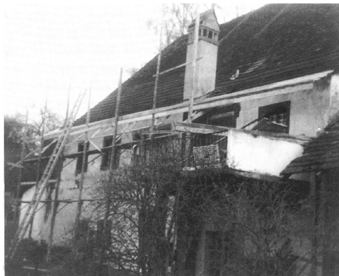
Süd/Westfassade vor Abbruch des Balkon.
