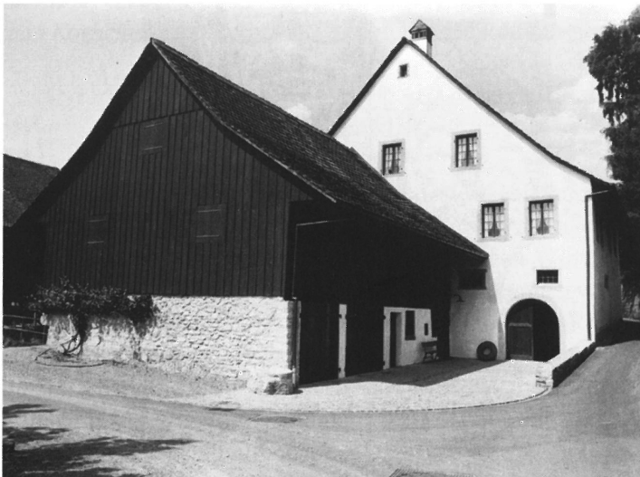
Alte Mühle im Dorf im heutigen Zustand.
