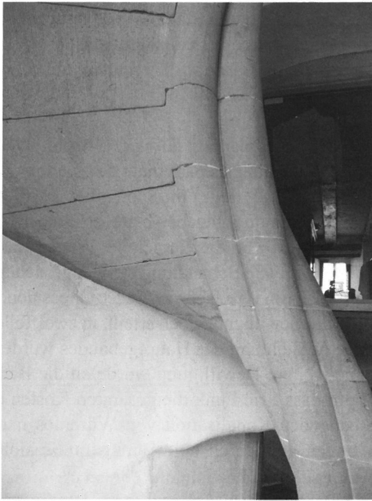
Original-Wendeltreppe im Turm. Der Dreiwulst windet sich zügig aufwärts.
