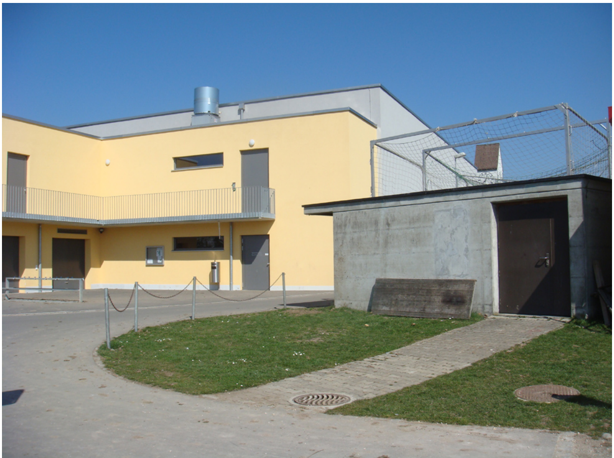
Standort des neuen Schuhwaschplatzes
