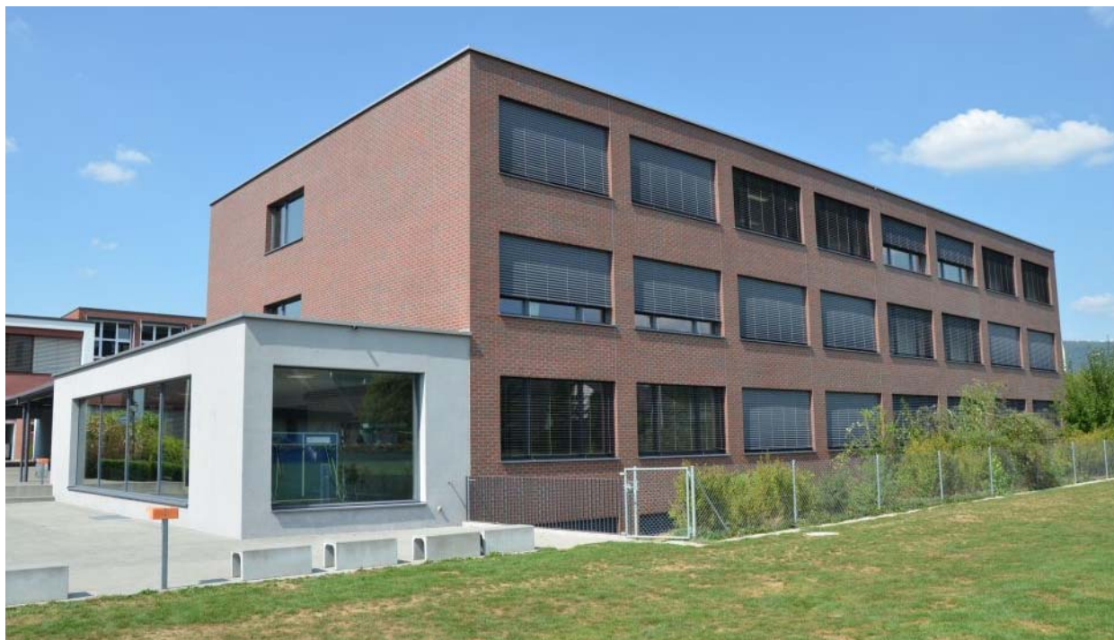
Fassade nach der Reinigung
