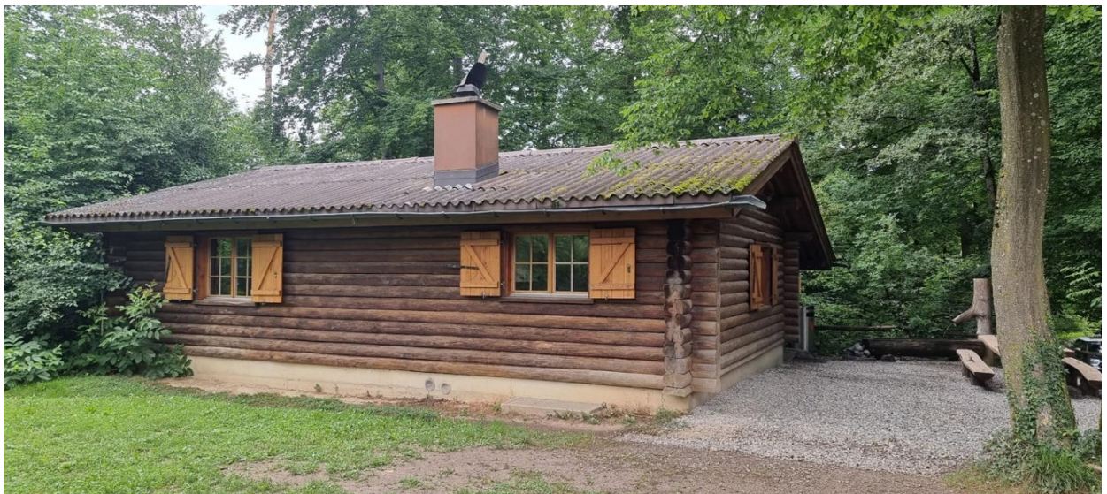
Forsthaus "Tägerhard", 1982 errichtet
