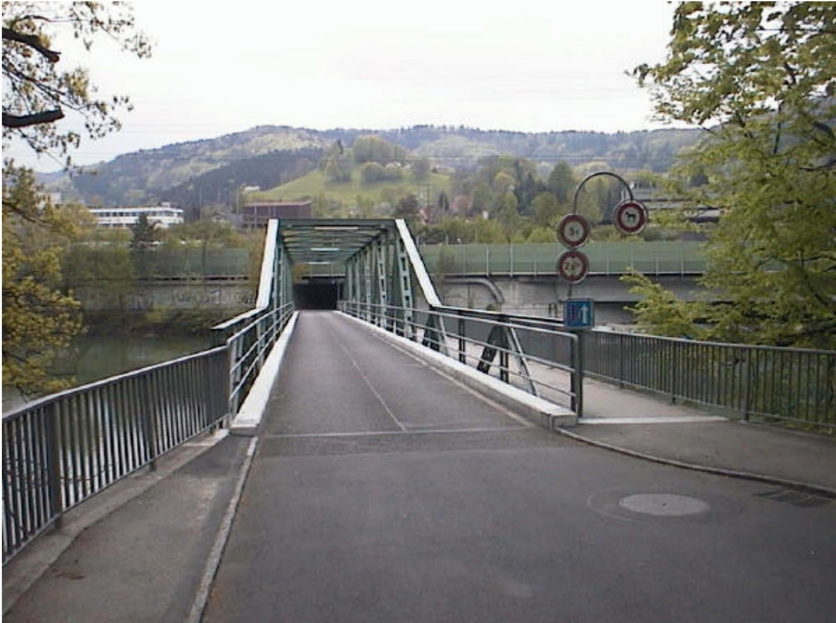
*Die sanierte Limmatbrücke Würenlos-Killwangen mit leicht breiterer Fahrbahn*
