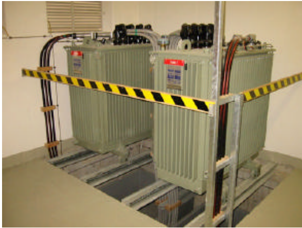
Transformatorstation (TS) "Ländli" - Links die Transformatoren 2 x 630 KVA, rechts die Mittelspannungsanlage
