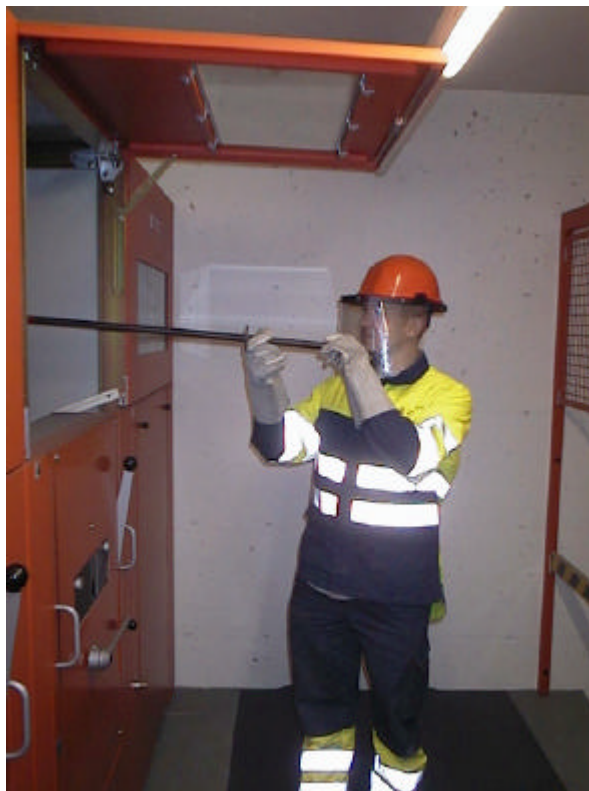
Adrian Wernli, Netzelektrikerlehrling, bei der Hochspannungs-Prüfung (links) und bei der Wartung eines Primär-Relais.
