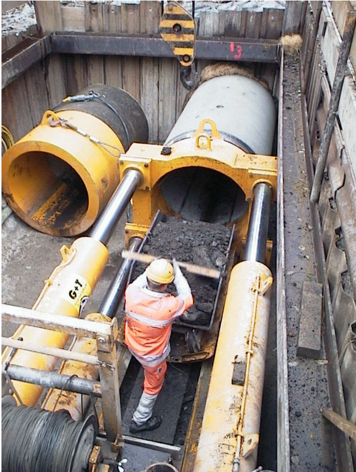
Pressschart und Pressrohrvortrieb
