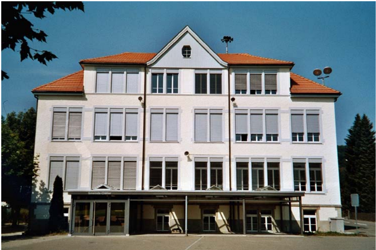
Das alte Schulhaus I, erbaut 1903, erstrahlt nach der Sanierung in neuem Glanz.
