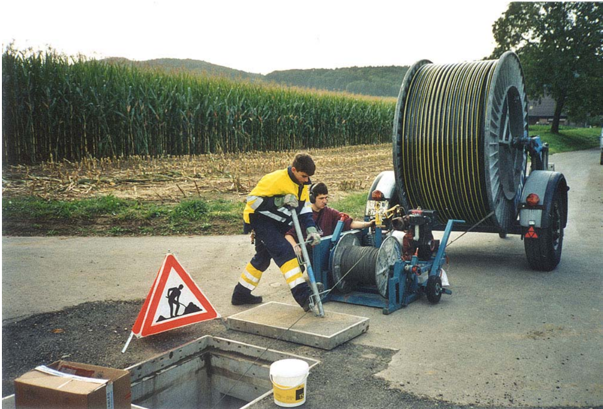
Adrian Friedli, Netzelektriker, und Sérgio Amaral, Netzelektrikerlehrling im 1. Lehrjahr, beim Kabelzug von der Trafostation "Steindlerstrasse" bis zur Liegenschaft Steindlerstrasse 7 (Niederspannungskabel 3 \times 150/150 \text{ mm}^2 , Länge 690 m).
