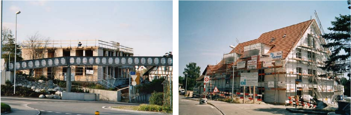
Die Neubauten an der Landstrasse 88 (links) und an der Dorfstrasse 8 (rechts).
