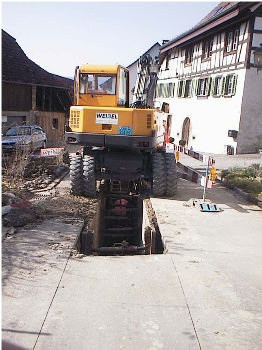
Strassen- und Werkleitungssanierungsarbeiten auf dem Abschnitt "Kempfhofstrasse"
