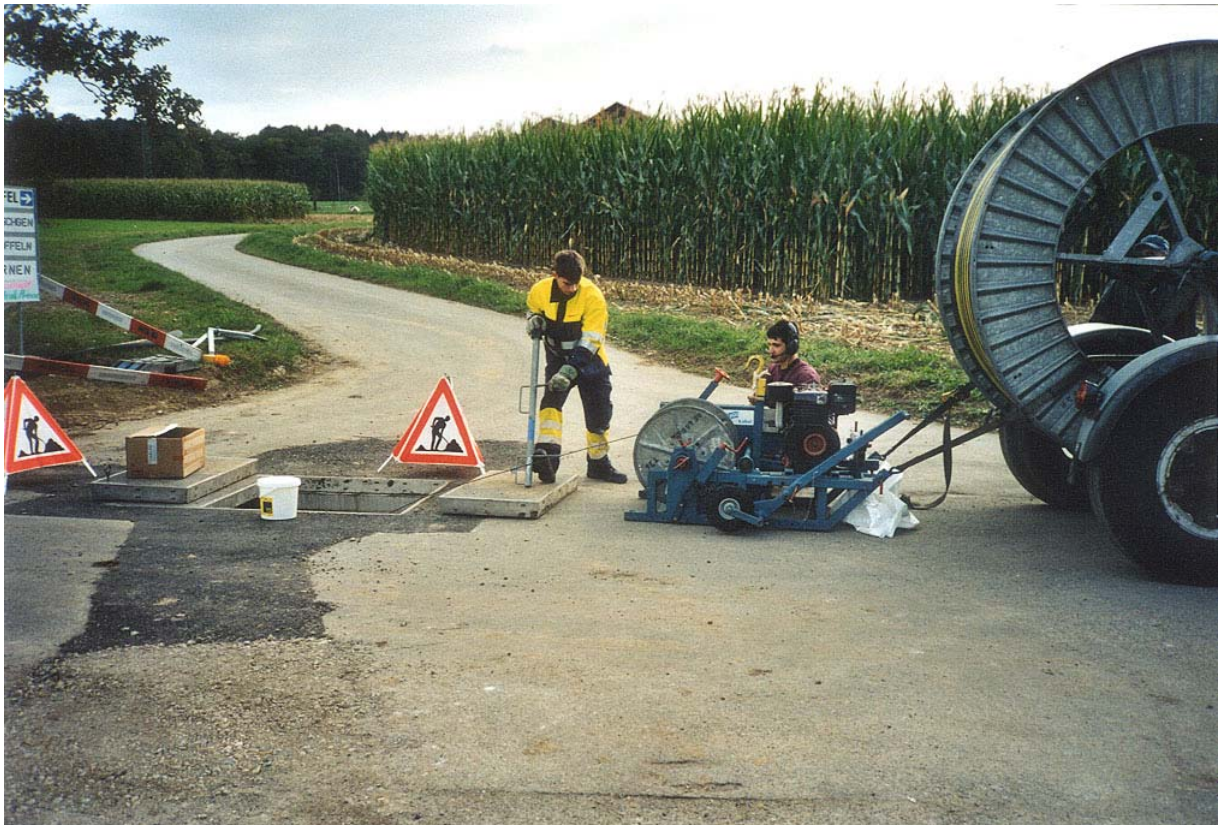
Adrian Friedli, Netzelektriker, und Sérgio Amaral, Netzelektrikerlehrling im 1. Lehrjahr, beim Kabelzug von der Trafostation "Steindlerstrasse" bis zur Liegenschaft Steindlerstrasse 7 (Niederspannungskabel 3 \times 150/150 \text{ mm}^2 , Länge 690 m).
