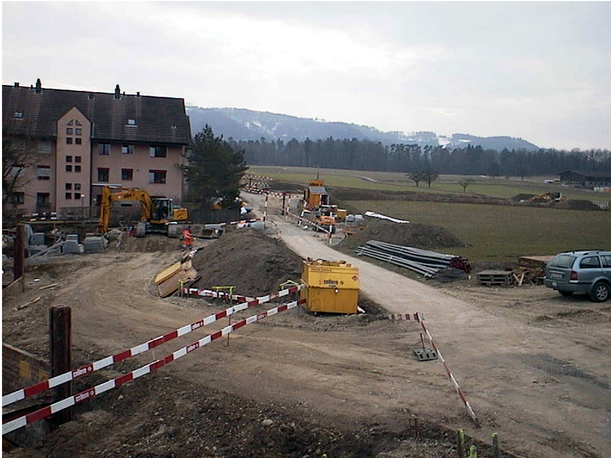
Baustelle zur neuen Erschliessung des Gebiets "Hürdli"
