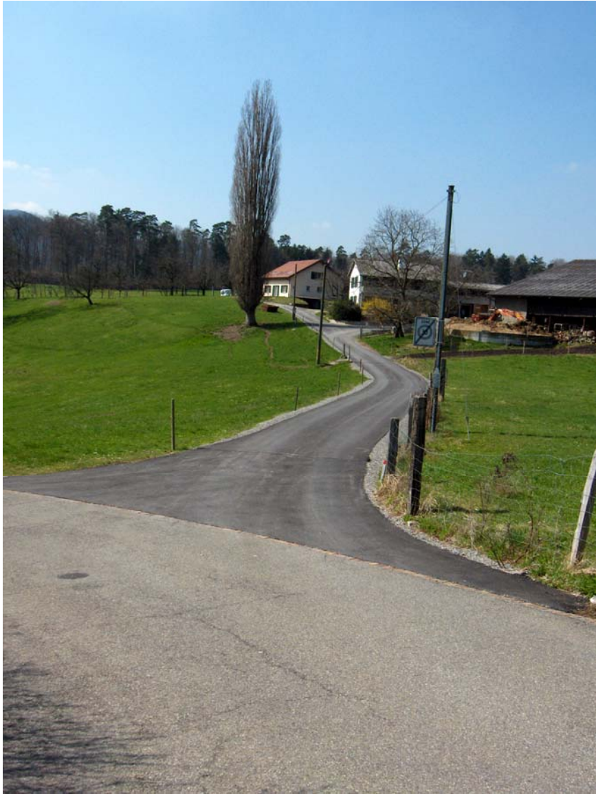
Saniertes Teilstück der Lättenstrasse
