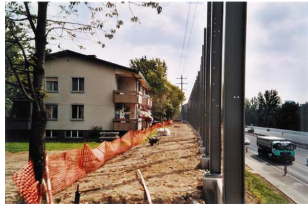
Sanierung und Erhöhung der Lärmschutzwände entlang der Autobahn A1 im Bereich "Schliffene"
