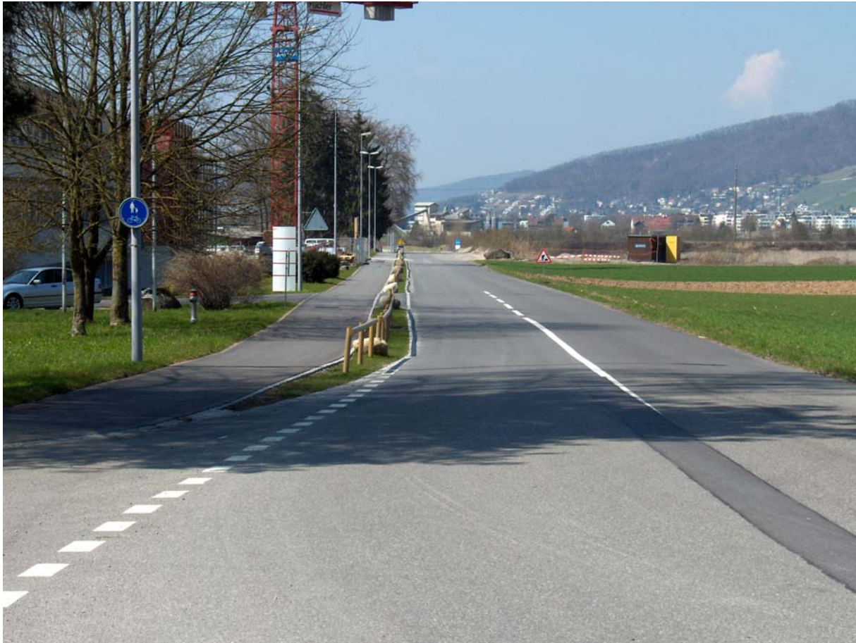
Der sanierte Abschnitt der Industriestrasse
