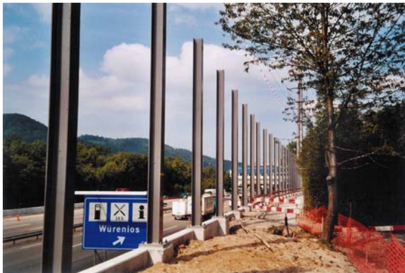
Sanierung und Erhöhung der Lärmschutzwände entlang der Autobahn A1 im Bereich "Schliffene"
