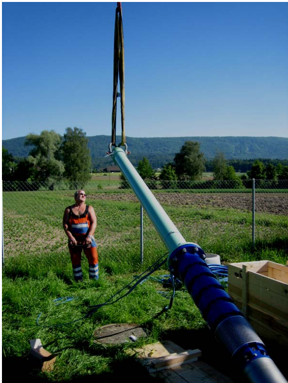
Ersatz der Grundwasserpumpe im Pumpwerk "Bettlen"
