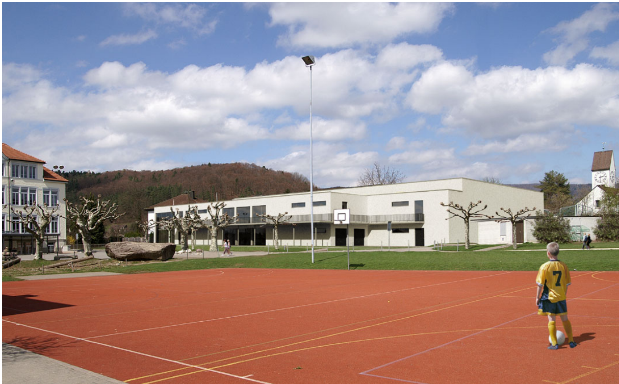
Aussenansicht der Mehrzweckhalle nach erfolgter Sanierung und Erweiterung
