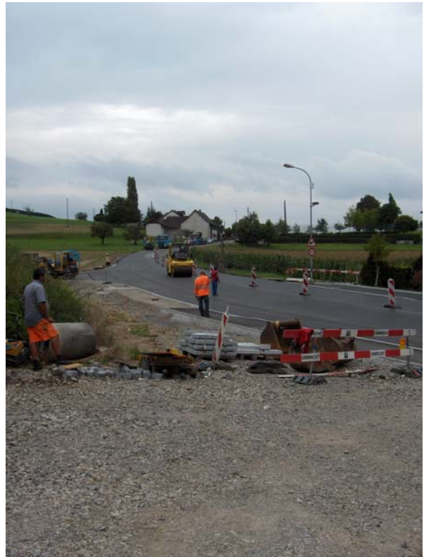
Der Gehweg vom Kreisel "Ländli" bis zum Bickacher ist erstellt (links). Die Bauarbeiten am Knoten "Bickacher": Einbau des Strassenbelags (rechts).
