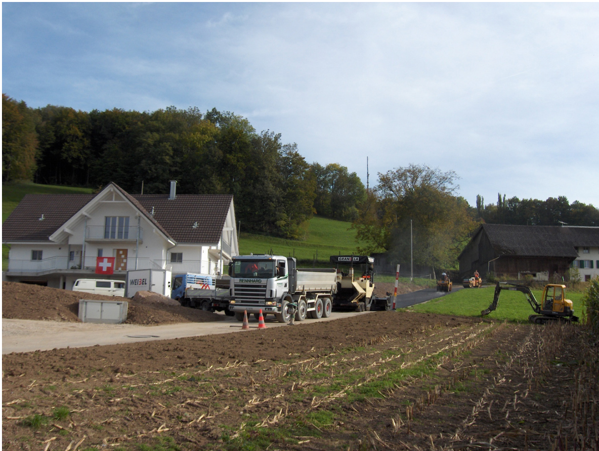
Belagseinbau an der Büntenstrasse (Dritte und letzte Etappe). Links das Wohnhaus der neuen landwirtschaftlichen Siedlung oberhalb des "Wiemels".
