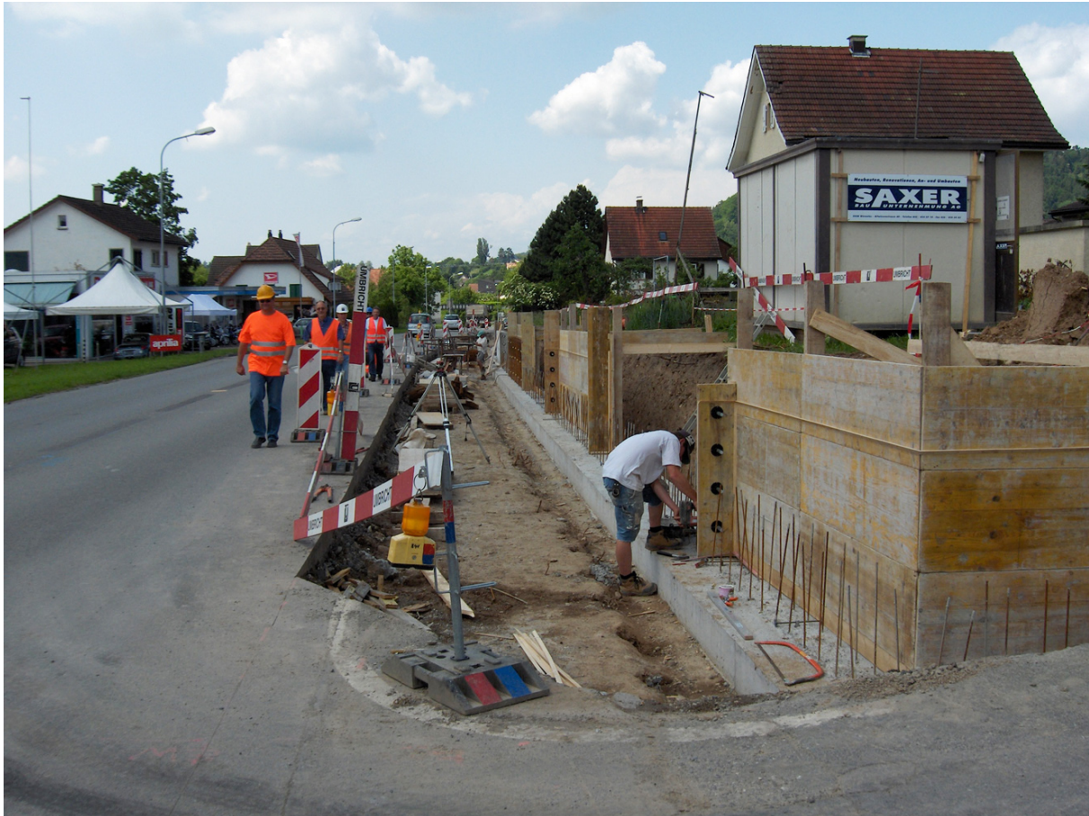
Arbeiten am neuen Gehweg entlang der Landstrasse. Die Mauer wird geschalt.
