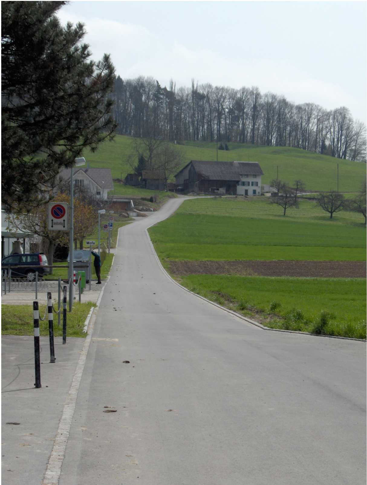
Die sanierte Büntenstrasse.
