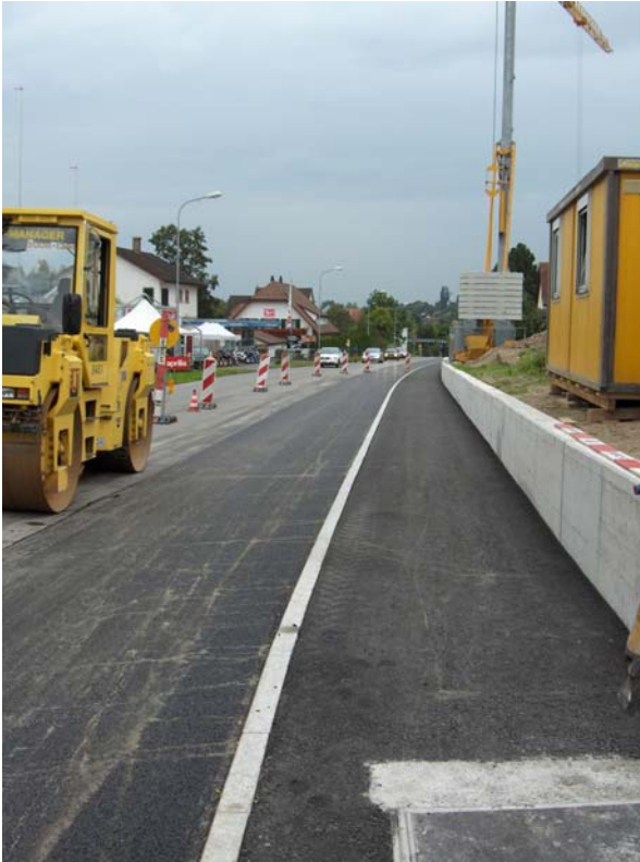
Der Gehweg vom Kreisel "Ländli" bis zum Bickacher ist erstellt (links). Die Bauarbeiten am Knoten "Bickacher": Einbau des Strassenbelags (rechts).
