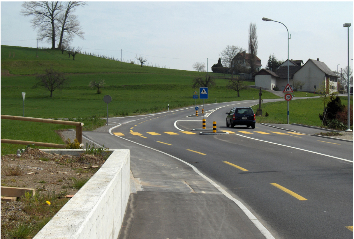
Der fertig gestellte Knoten "Bickacher" in Betrieb.
