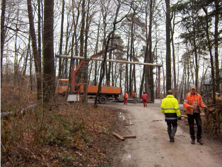
Pumpversuch Tägerhardwald: Einrichtung der Strassenüberquerung
