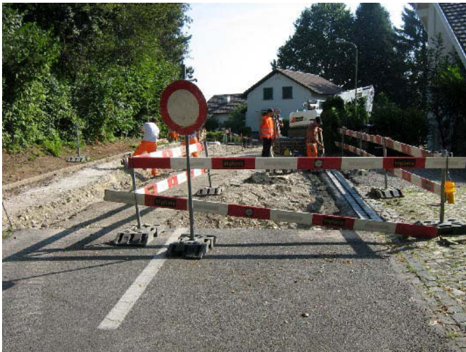
Erneuerung der Strasse (Versetzen und Abstecken der Randabschlüsse)
