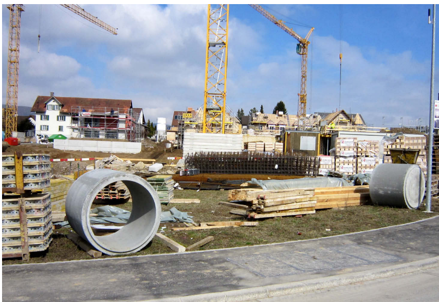
Mehrere Baustellen prägen das Bild beim "Bickacher"
