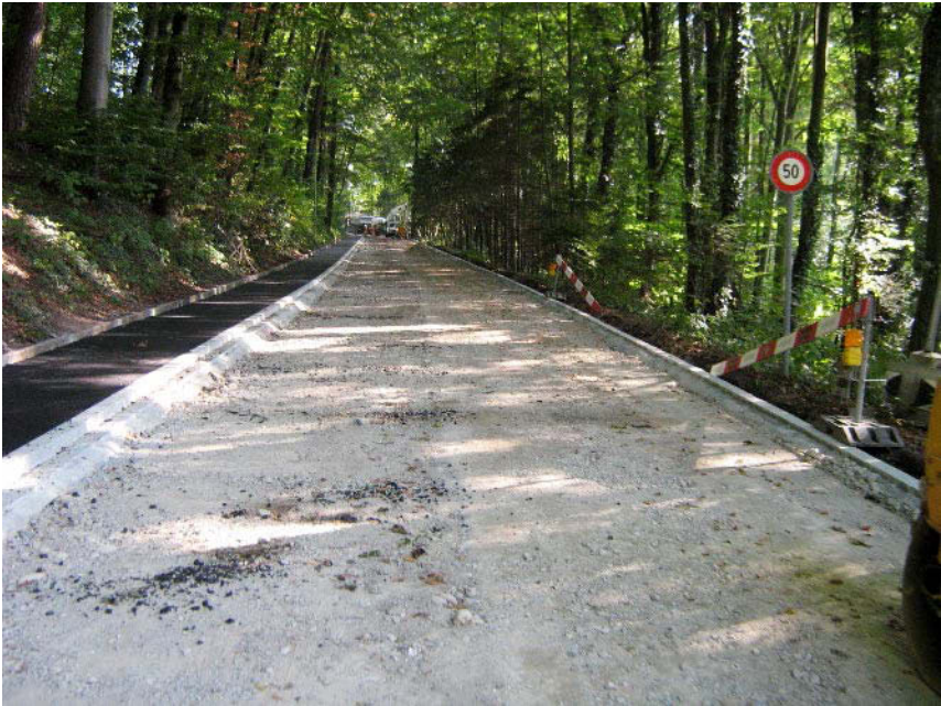
Fertige Planie der Buechzelglistrasse im Buechwald mit dem erneuerten Gehweg und den neuen Fahrbahnabschlüssen
