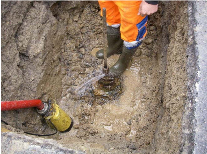
Defekter Wasserleitungsschieber
