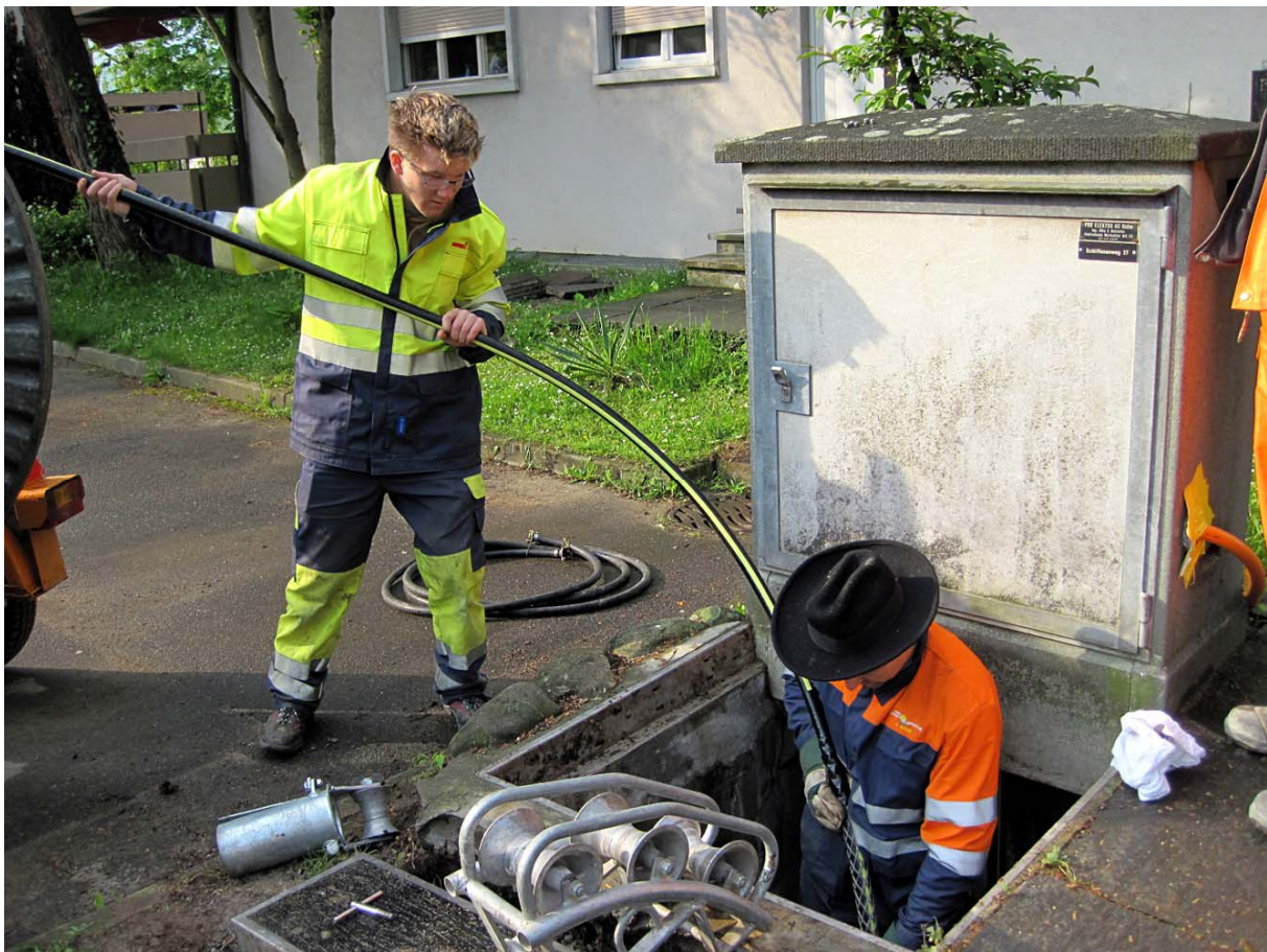
Die TBW-Netzelektriker bei Kabelzugarbeiten bei der Verteilkabine am Schliffenenweg 37
