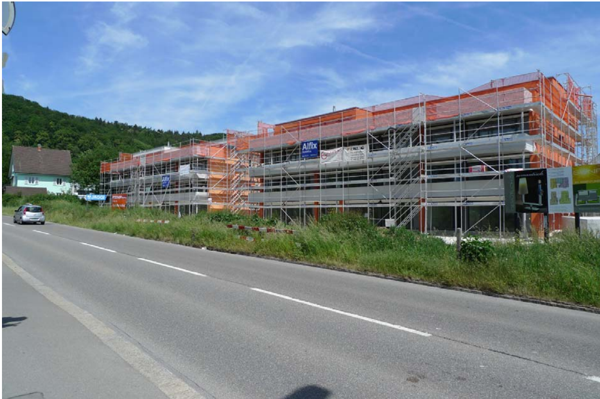
Am Kohlgrubenweg entstehen neue Mehrfamilienhäuser
