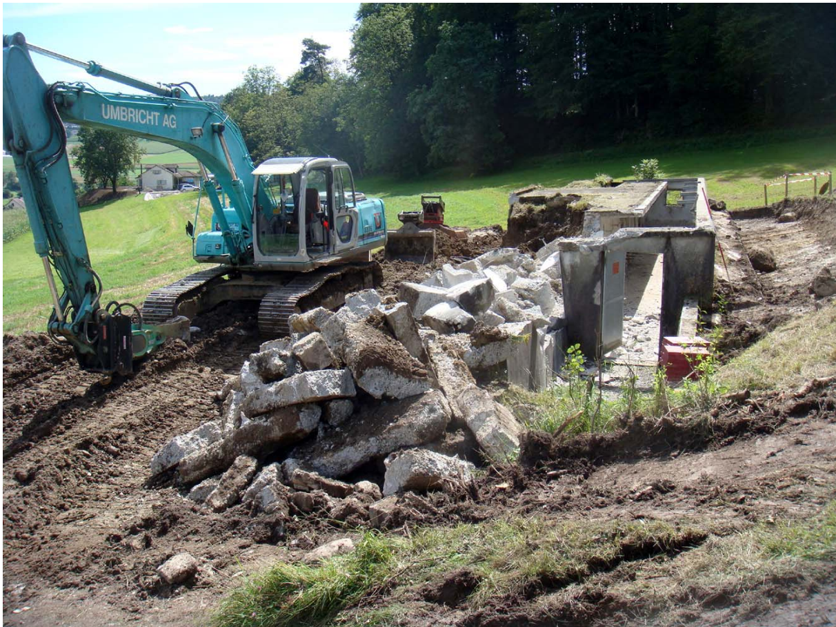
Die massive Konstruktion des abgebrochenen Scheibenstandes
