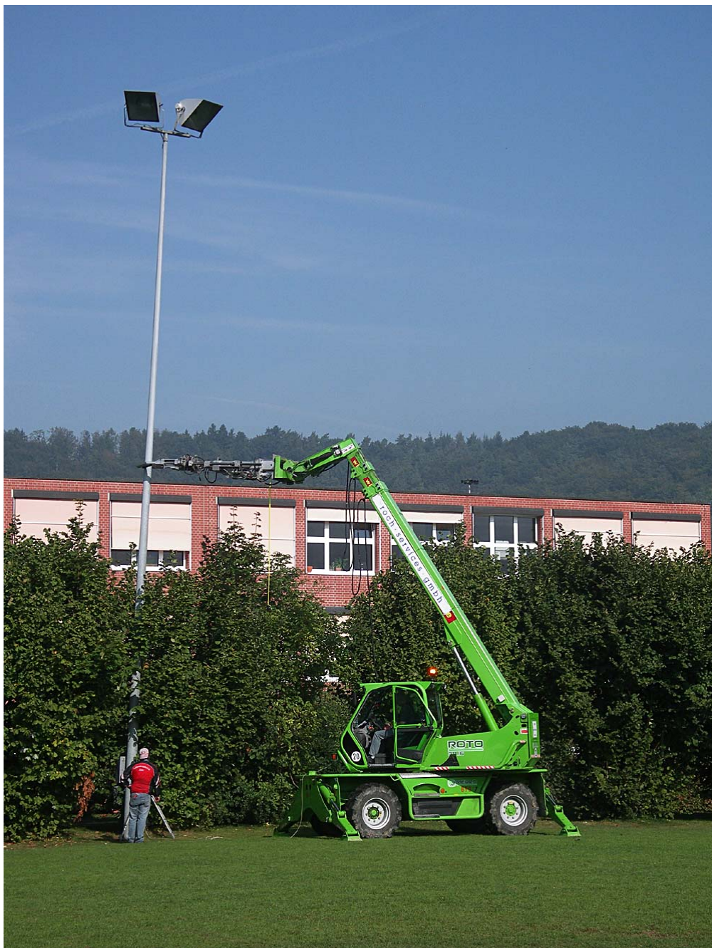
Standsicherheitsprüfung der Beleuchtungsmasten beim Sportplatz "Ländli"
