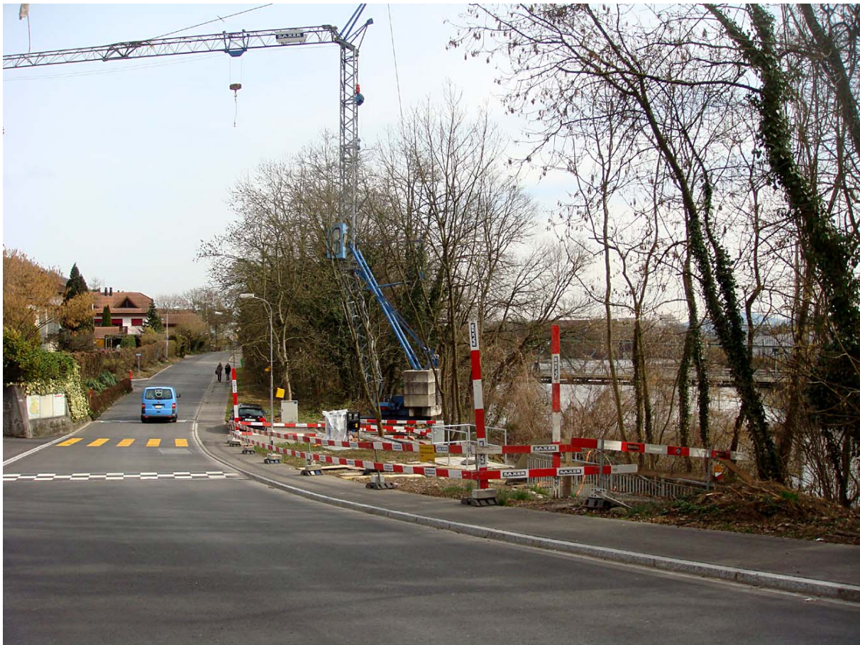
Die "Sorgenbaustelle" Abwasserpumpwerk "Altwies"
