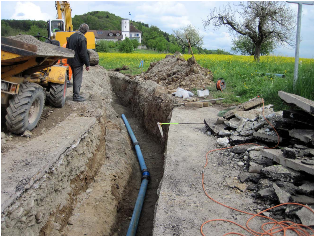
Werkleitungssanierung "Bickguet", Verlegung der neuen Wasserleitung
