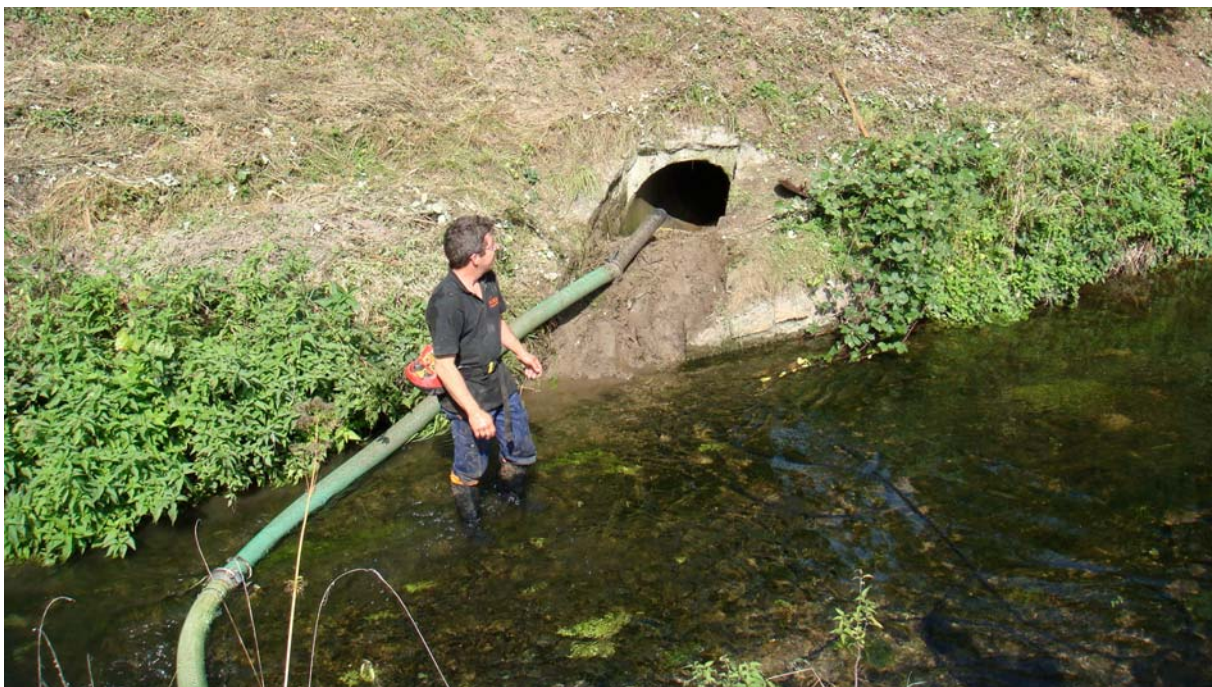
Beträchtliche Ablagerungen konnten mit der Spülung beseitigt werden.
