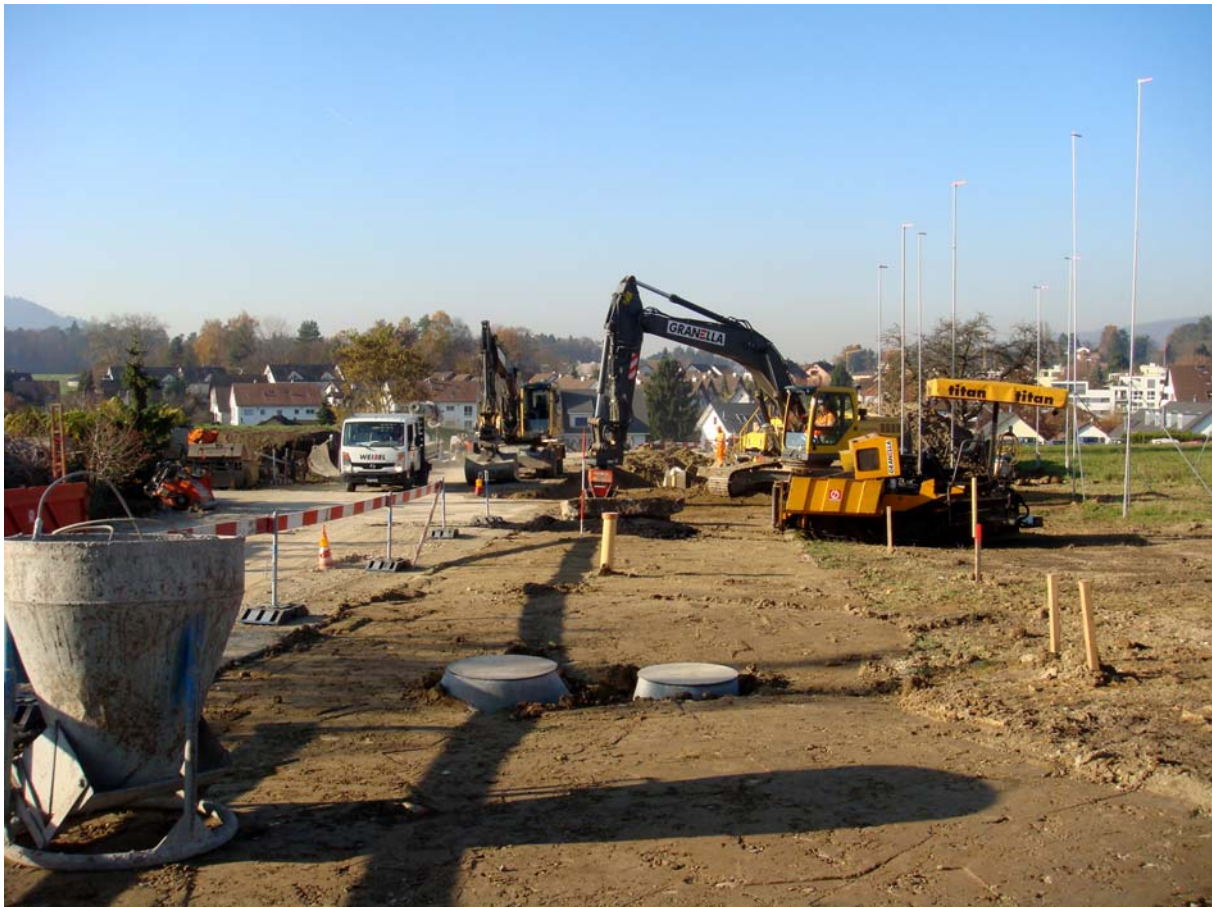
Die Erschliessungsstrasse für den "Huebacher" wird erstellt.
