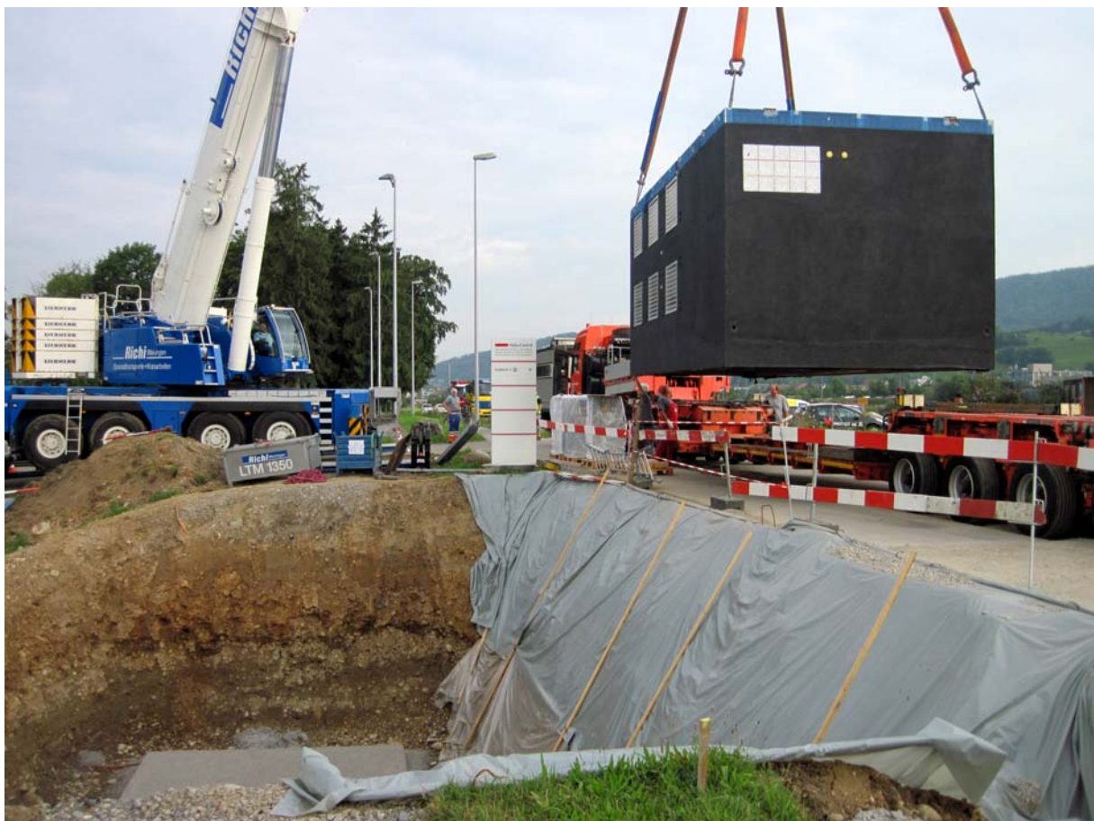
Anlieferung und Montage der Trafostation "Industriestrasse" (vor der Huba Control AG).
