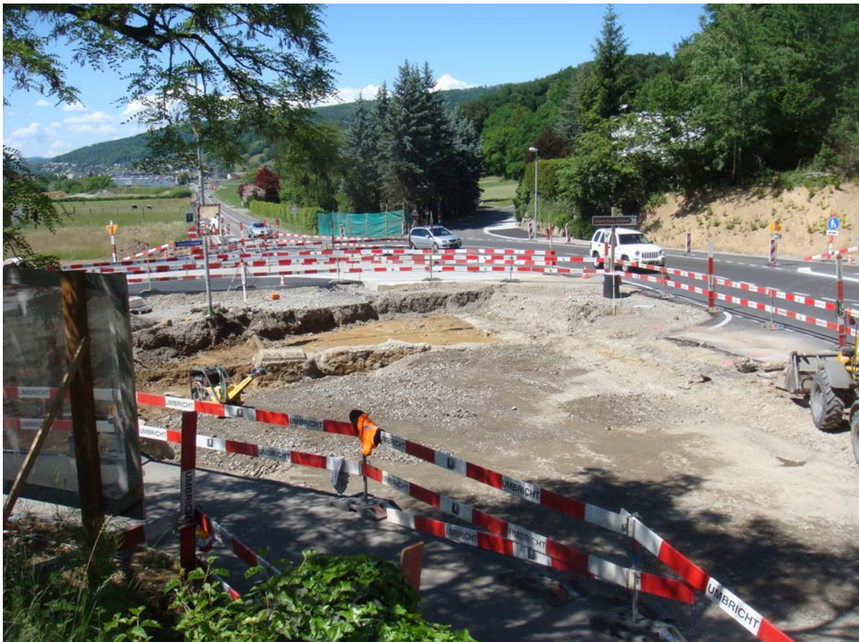
Bauarbeiten am Kreisel "Steinbruch": Das Zentrum des Kreisels entsteht.
