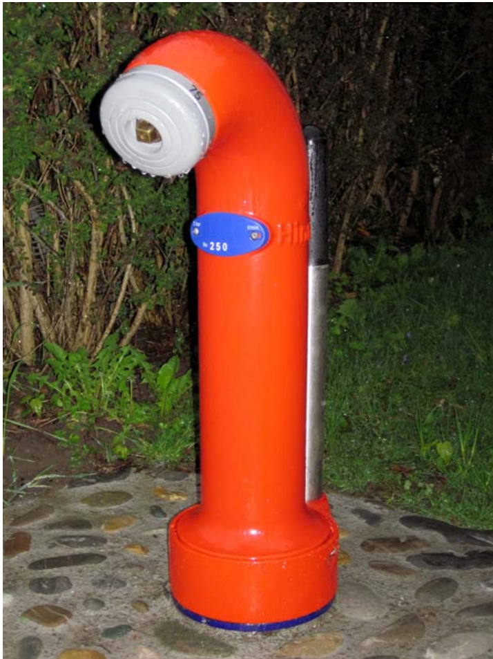
Der Hydrant mit der Nr. 250. Am Gartenweg wurde der 250. Hydrant des gesamten Gemeindegebiets gesetzt
