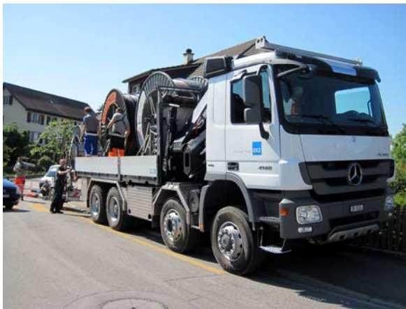
Mittelspannungskabelzug Trafostation Unterdorf - Trafostation Oberdorf.
