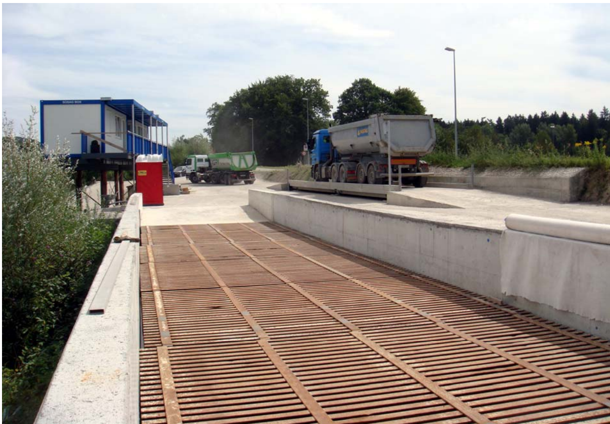
Erstellung des Lastendurchfahrtsbeckens.
