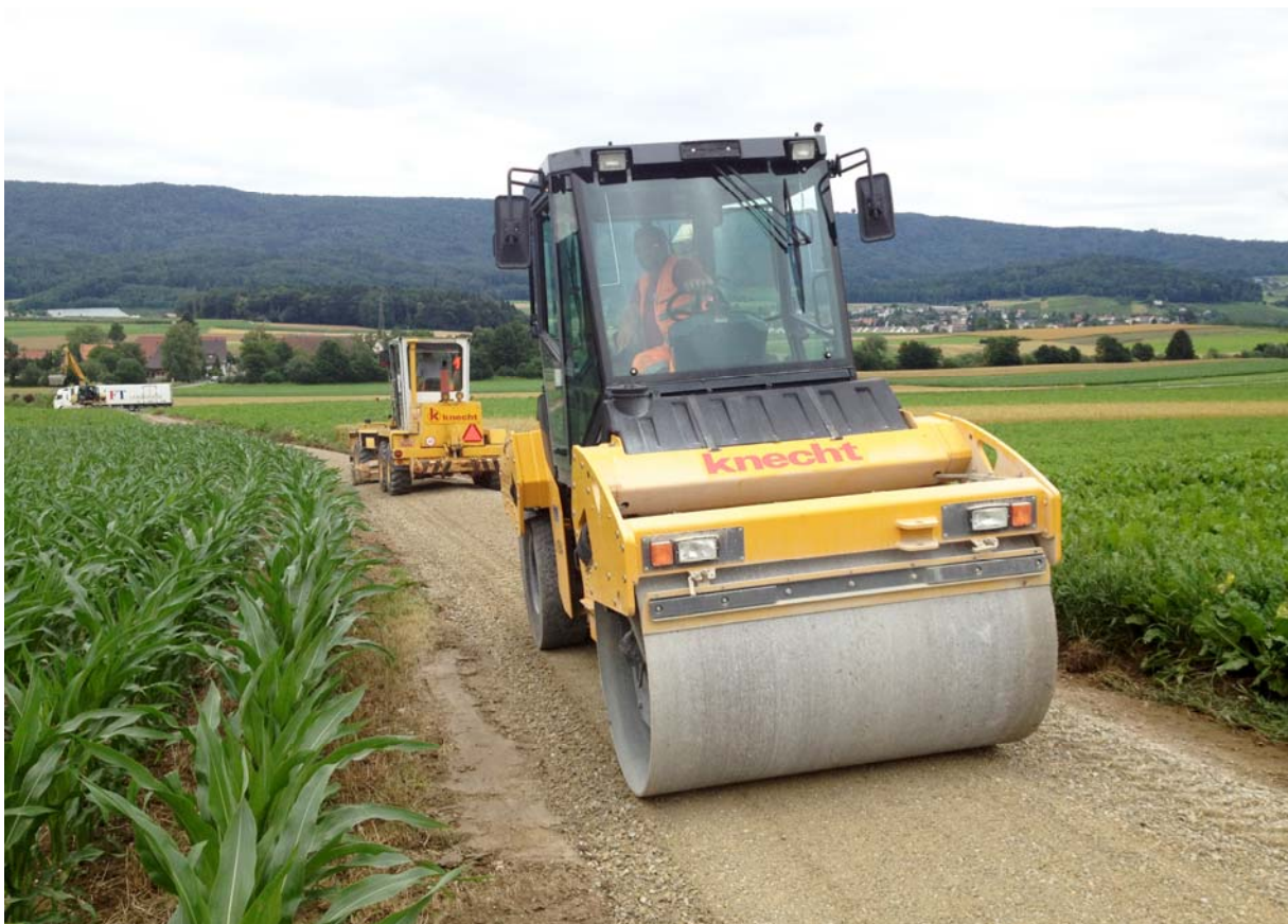
Flurwegsanierung: Mit der Walze wird der Boden einvibriert.
