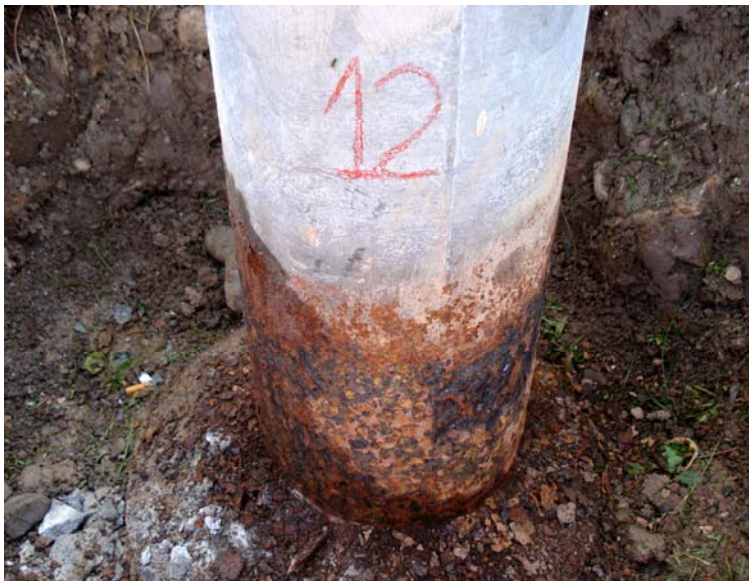
Korrosionsschutz für Lichtmasten der Sportanlage "Ländli".
