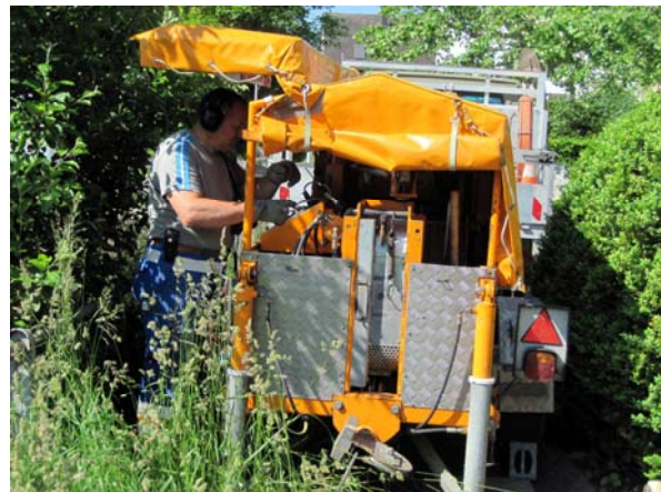
Mittelspannungskabelzug Trafostation Unterdorf - Trafostation Oberdorf.
