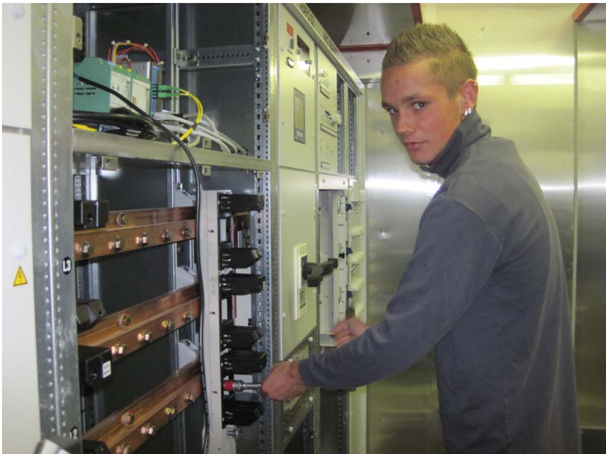
TS Bahnhofstrasse Tom Schaumann bei Installationsarbeiten
