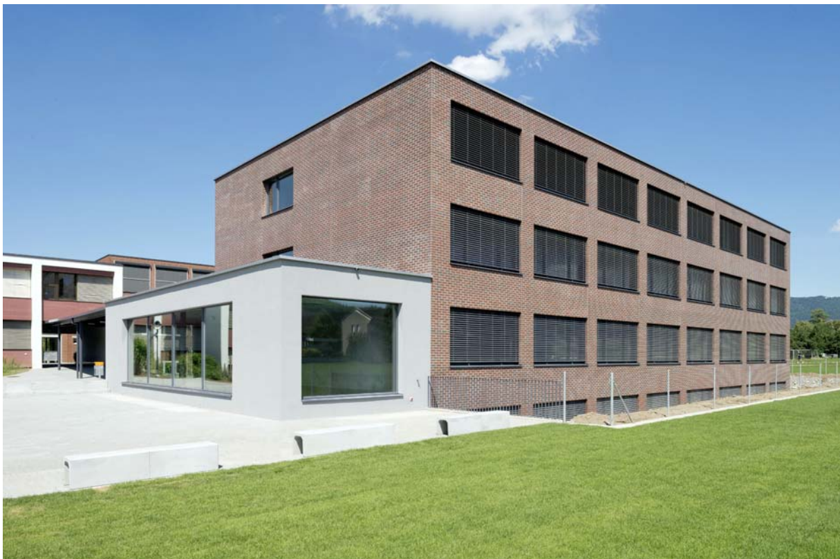
Neubau Schulhaus "Feld": Das Schulhaus konnte zum Beginn des Schuljahres 2013/2014 in Betrieb genommen. Die feierliche Einweihung fand am 21. September 2013 statt.
