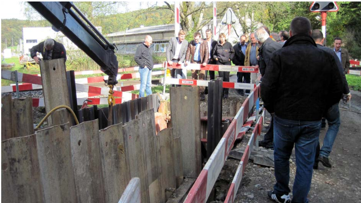
Baubeginn der SBB-Unterquerung im "Tägerhardwald" am 18. Oktober 2013
