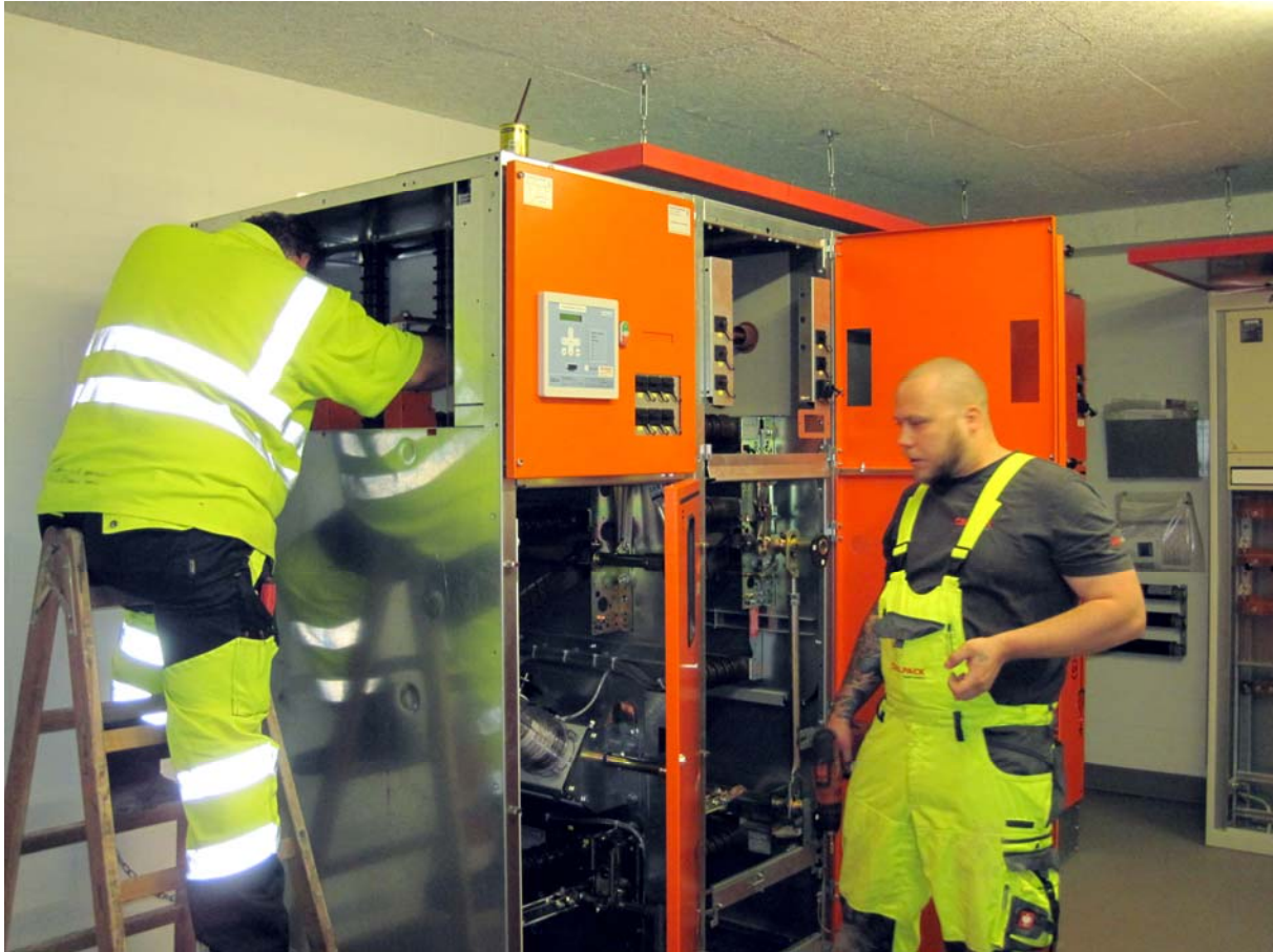
Trafostation "Grosszelg": Montage der neuen Mittelspannungszelle
