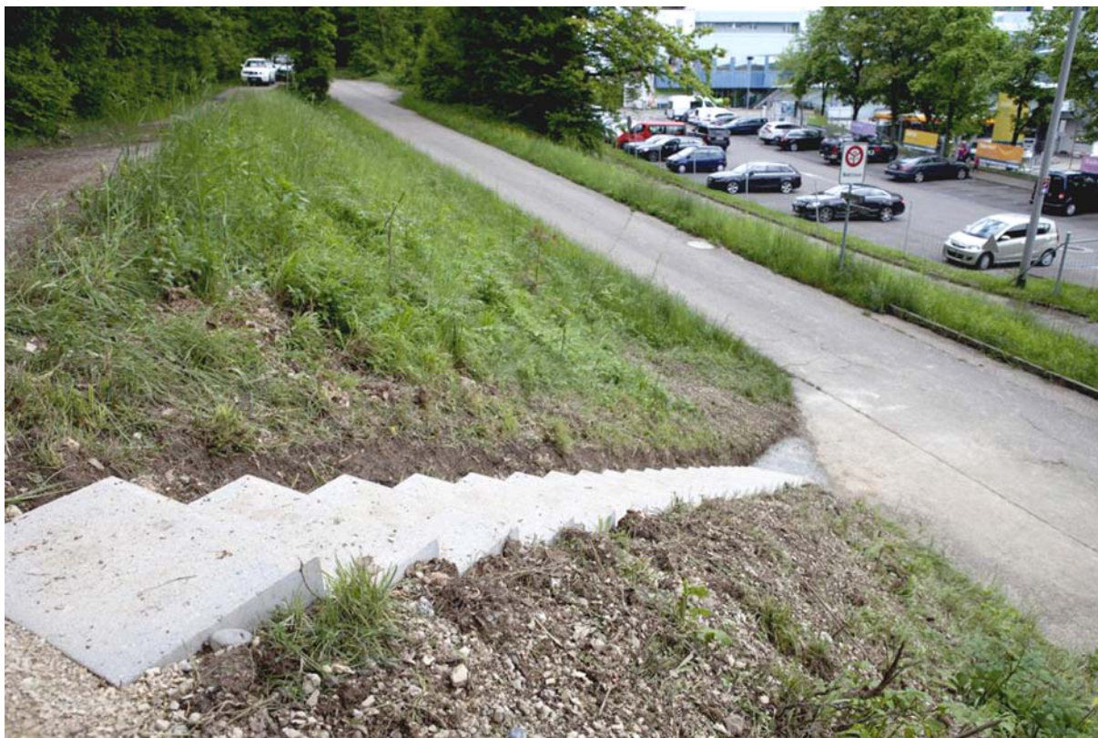
Vom Zivilschutz neu erstellte Treppe im Trägerhardwald, oberhalb Autobahnraststätte
