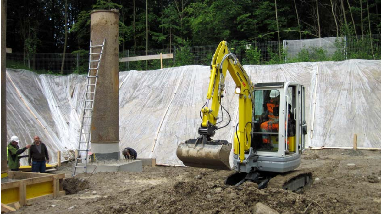
Grundwasserpumpwerk "Tägerhardwald": Einbetonieren der Bodenplatte mit Brunnenrohr
