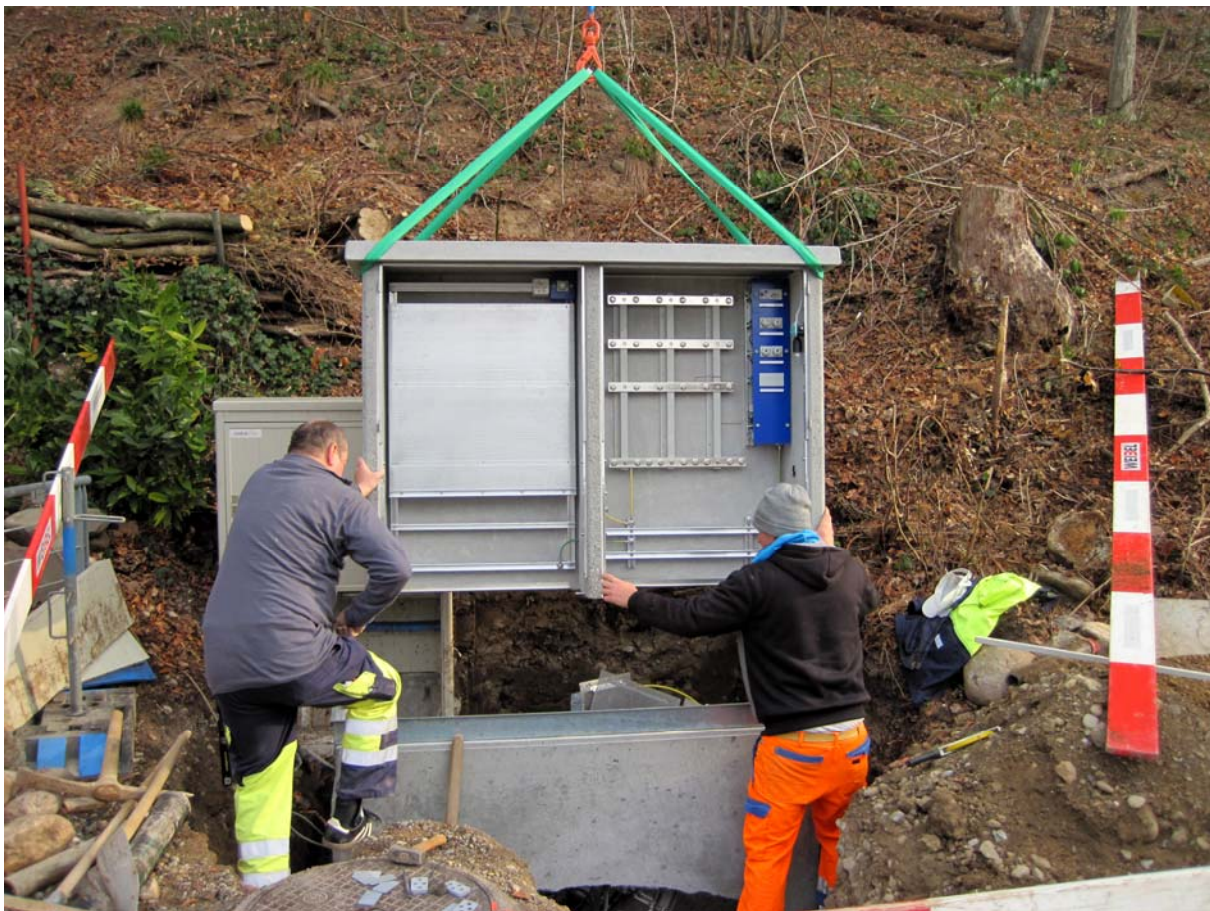
Werkleitungssanierung am Taunerwiesenweg: Montage Verteilkabine
