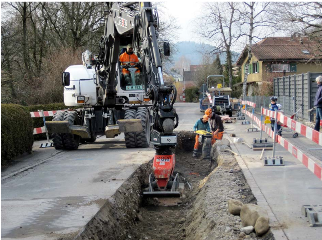
Werkleitungssanierung Altwiesenstrasse Etappe 1
