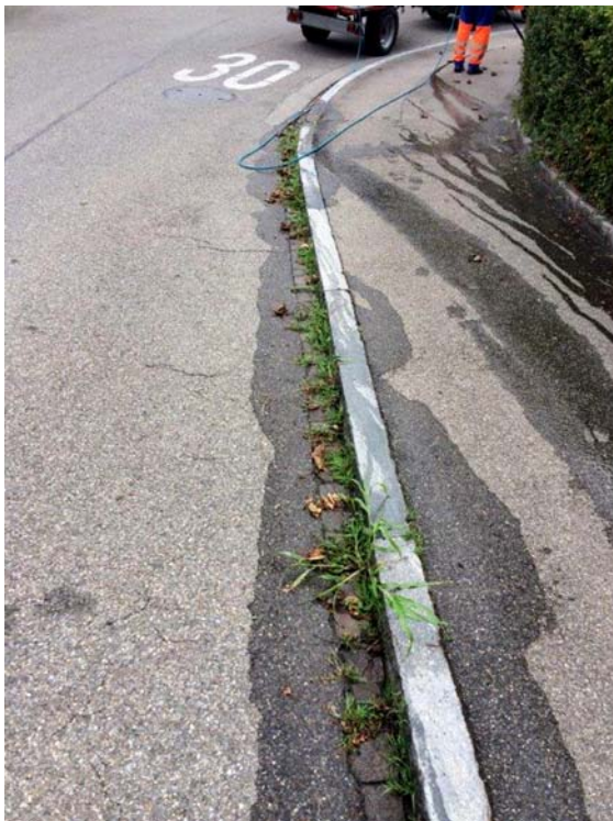
Fugensanierung an den Strassenrändern: vorher - nachher.
