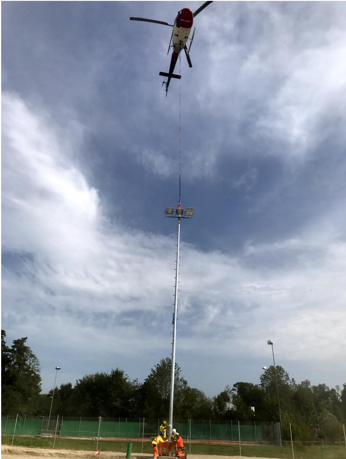
Die Beleuchtungsmasten für den neuen Sportplatz "Tägerhard" wurden mithilfe eines Helikopters versetzt.
