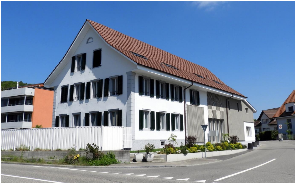
Erstrahlt nach der Sanierung mit Umbau in neuem Glanz: Die Liegenschaft Dorfstrasse 1 (ehemals Landstrasse 53), welche unter kommunalem Schutz steht.
