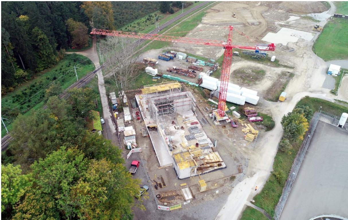
Baustelle für den Neubau des Werkhofs "Tägerhard".
