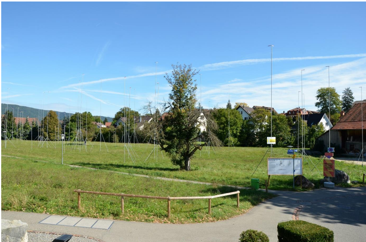
Profile für den geplanten Alterszentrumbau auf der Zentrumswiese.
