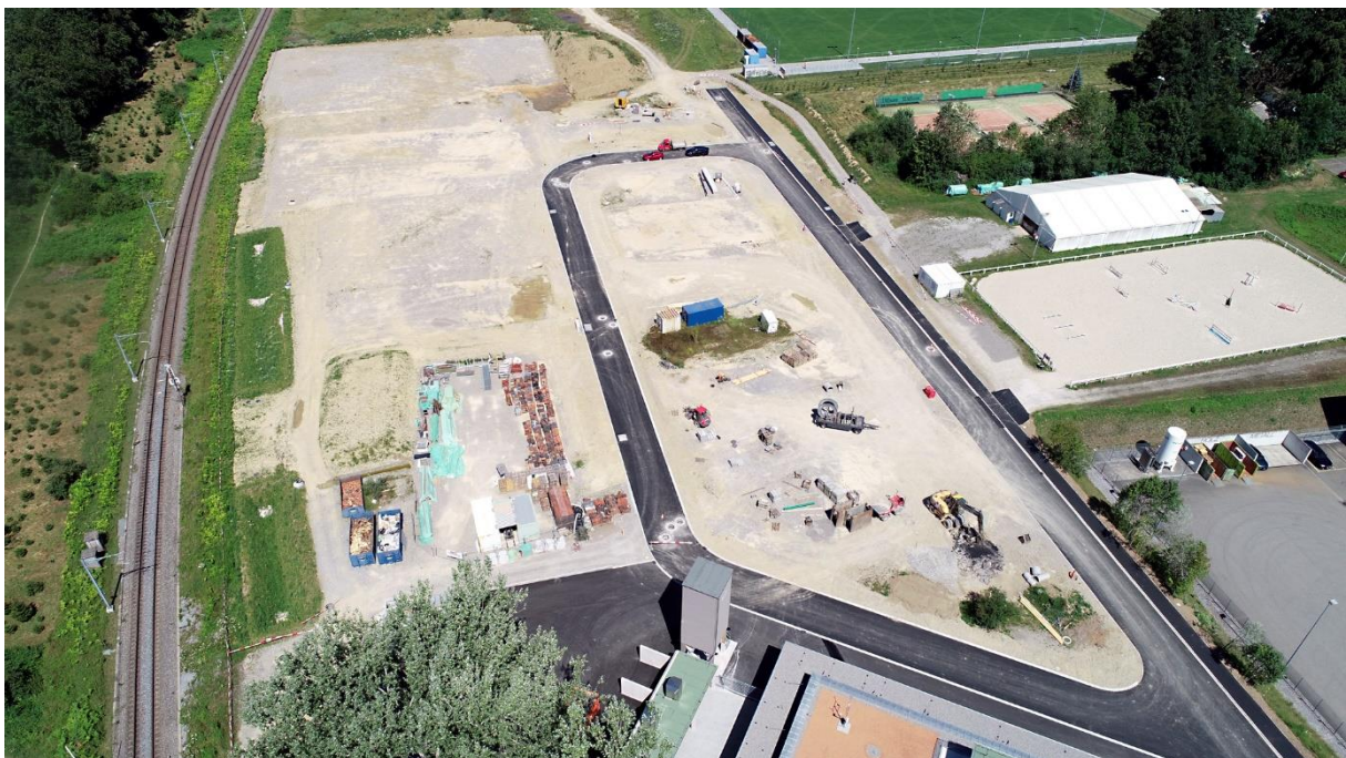
Das Gewerbegebiet im "Tägerhard" wird erschlossen: Die neue Strasse - der Tägerhardring - ist erstellt.
