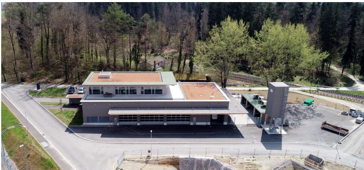
Der neue Werkhof "Tägerhard" samt Umgelände.
