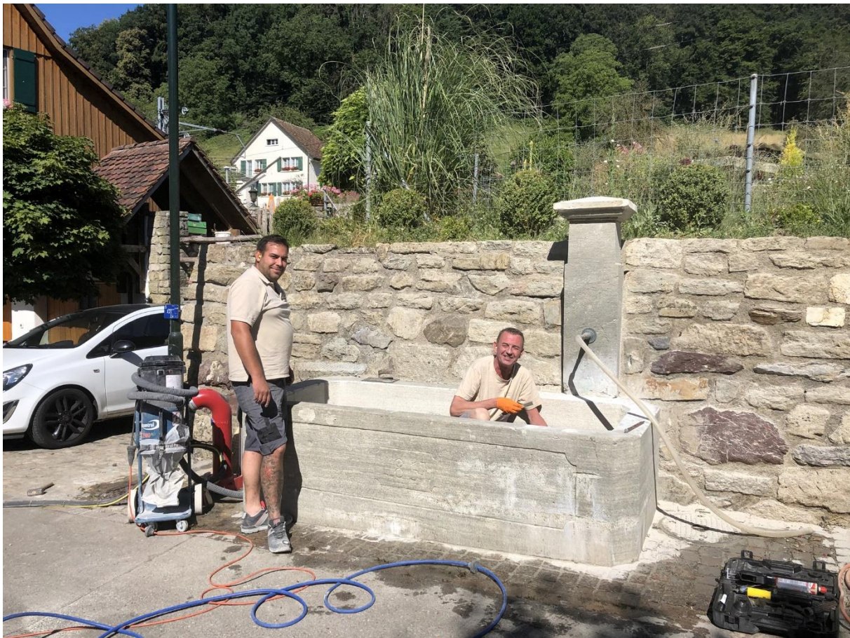
Sanierungsarbeiten am Brunnen an der Kempfhofstrasse.
