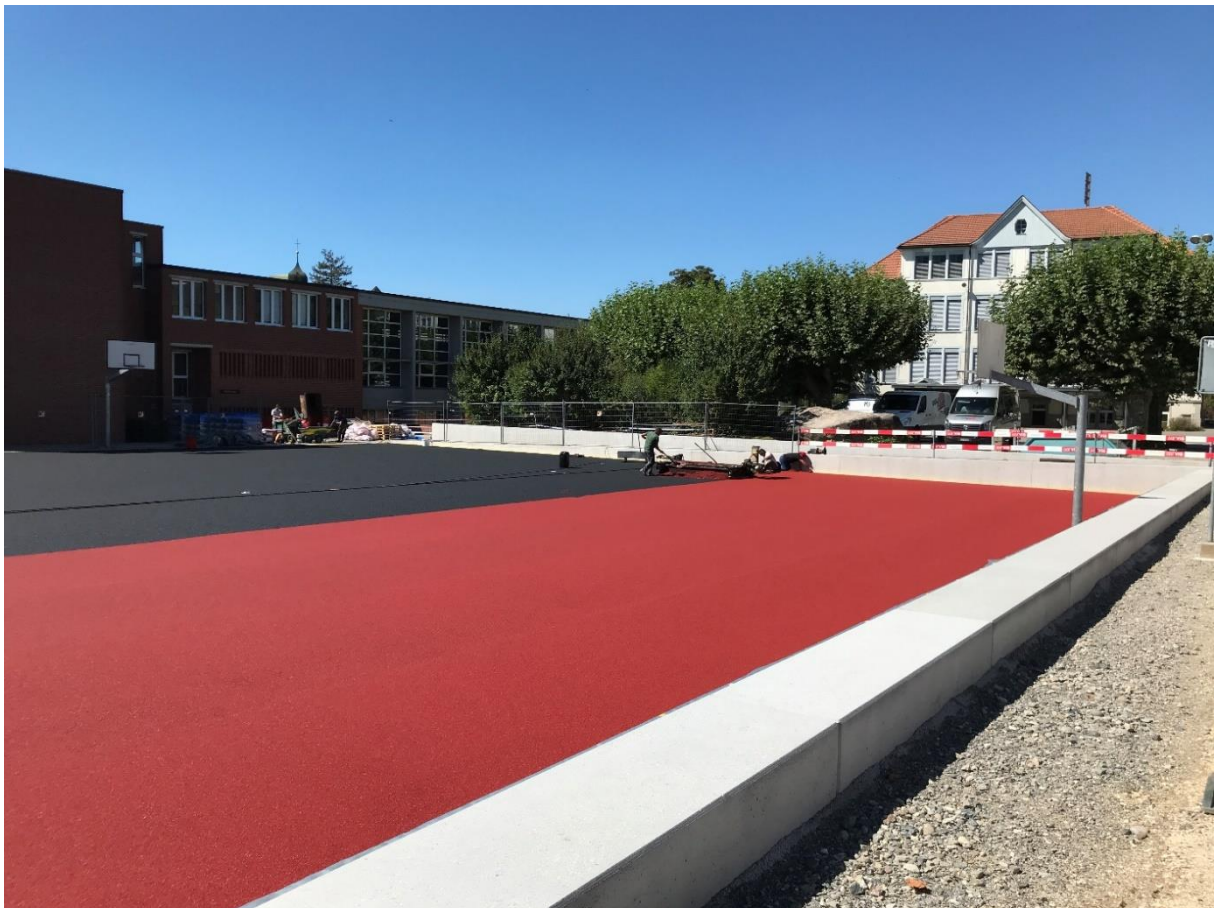
Sanierung Roter Platz: Anlieferung der Beleuchtungsmasten per Helikopter (oben) und Einbau des Tartanbelags (unten)
