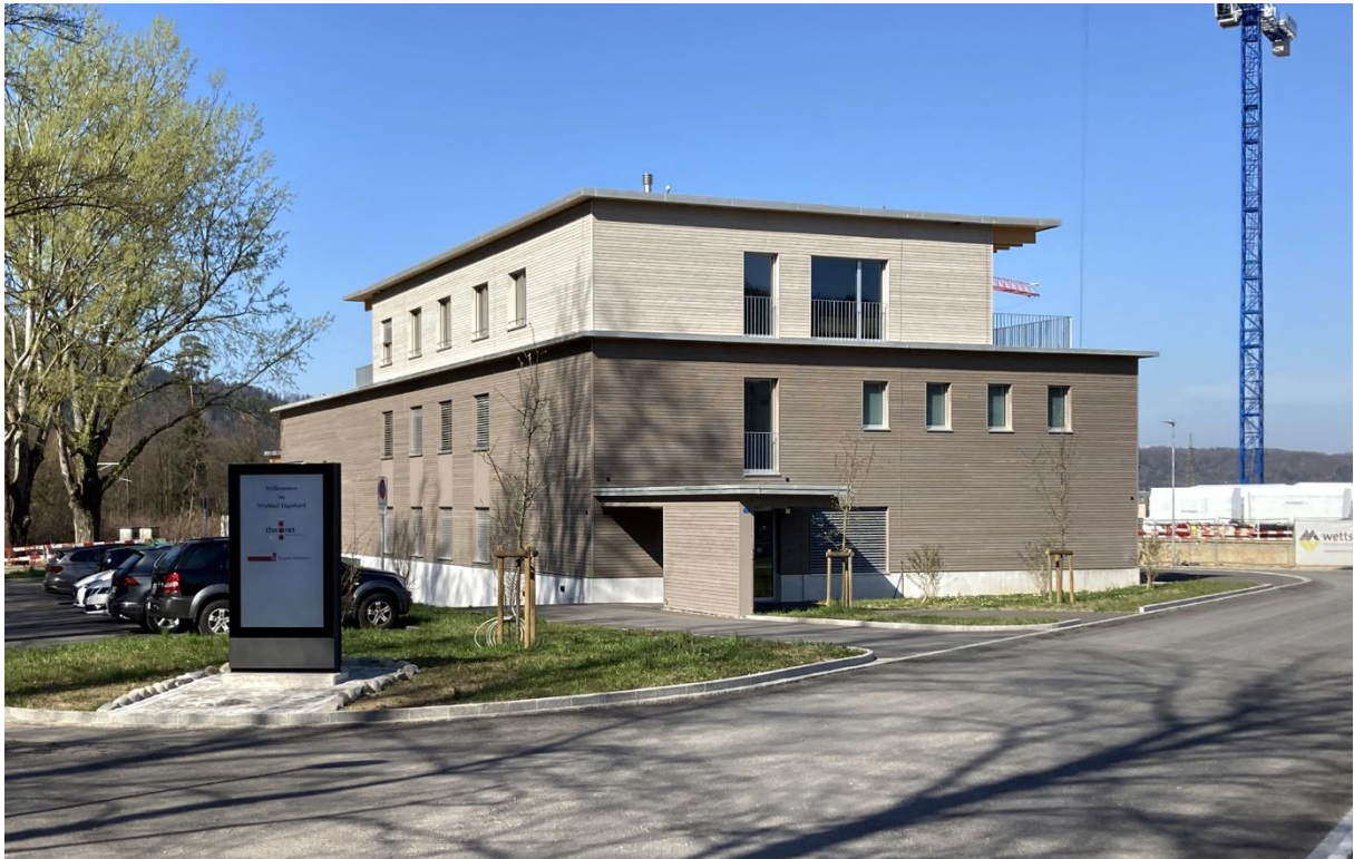
Der Werkhof "Tägerhard" an der Tägerhardstrasse 1.
