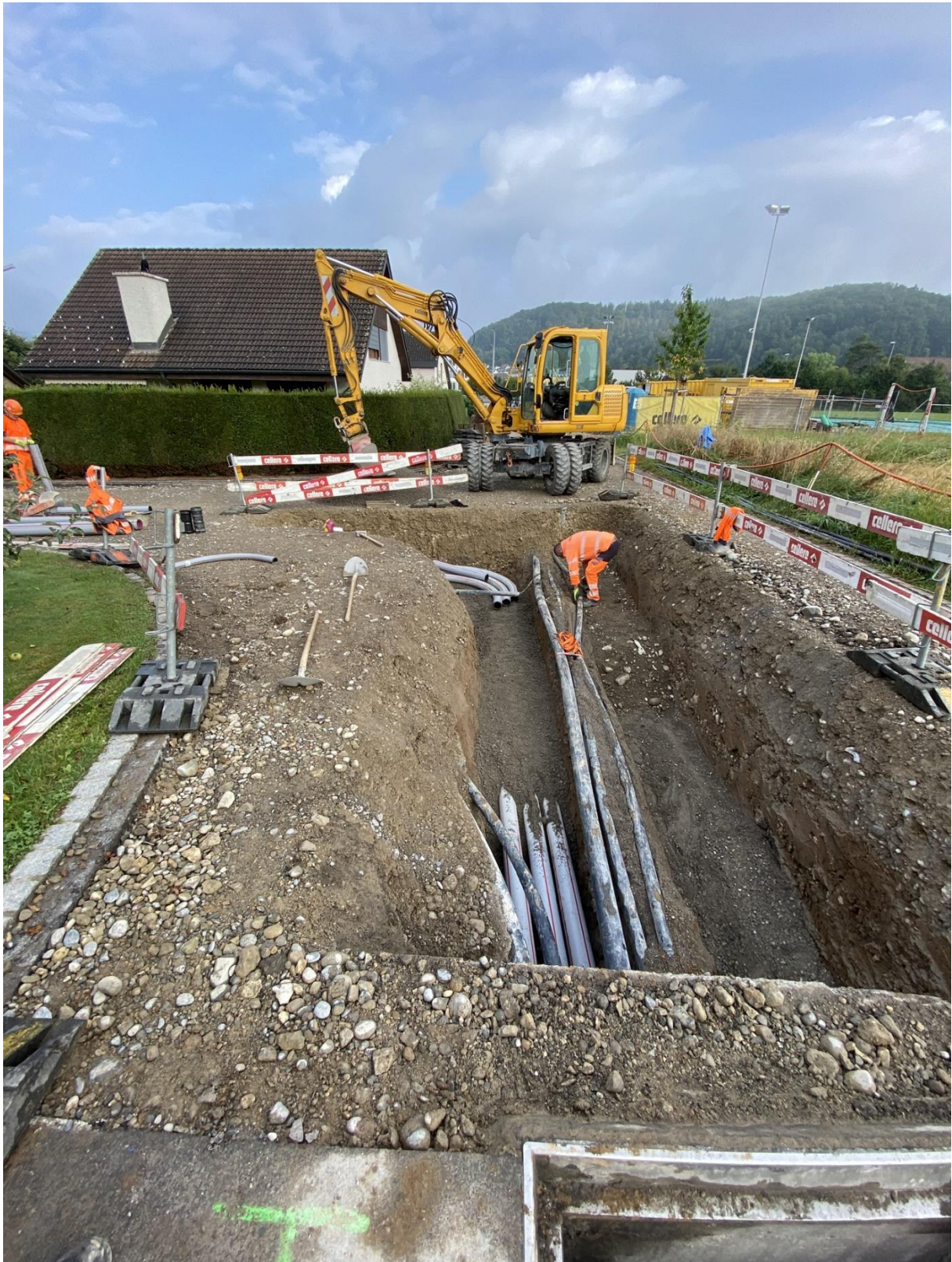
Verkantungssanierung an der Mattenstrasse
