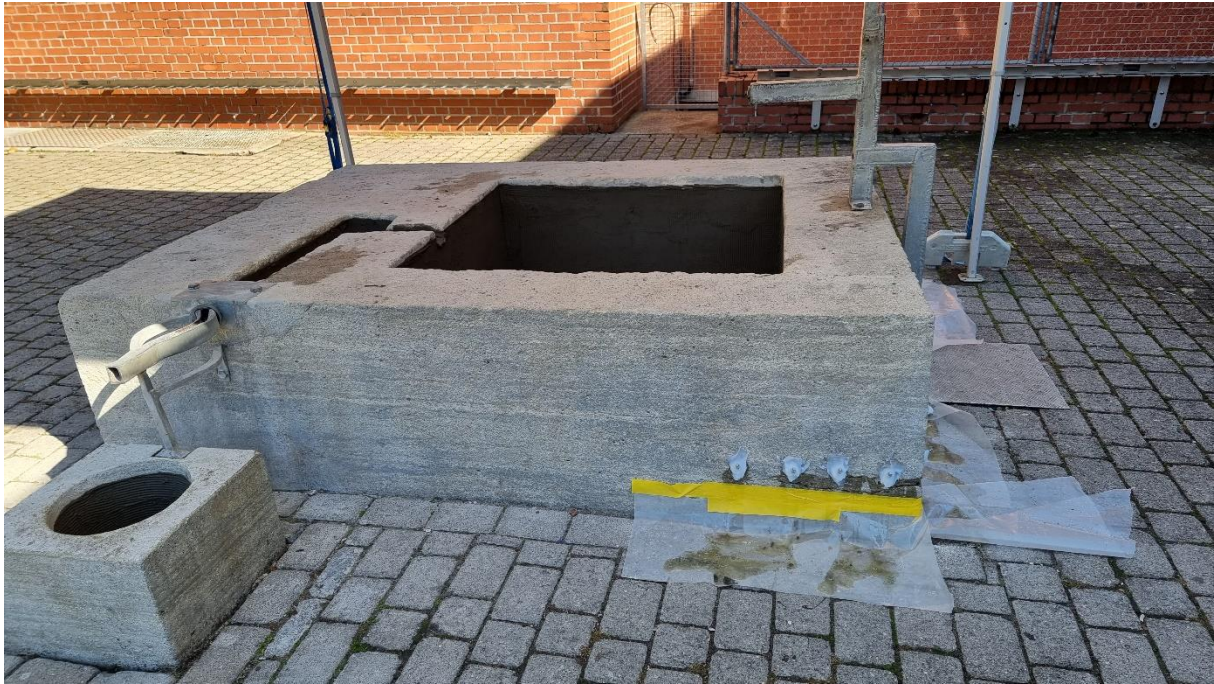
Sanierung des Brunnens beim Schulhaus "Ländli"
