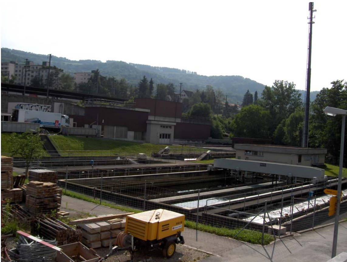
Abwasserreinigungsanlage der Gemeinden Killwangen, Spreitenbach und Würenlos im Gebiet "Schniderhau", Killwangen
