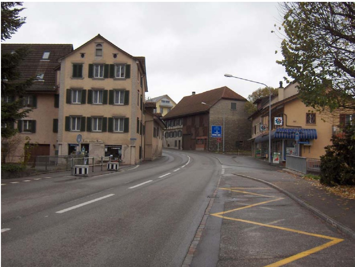
Furtbachbrücke mit den "Sofortmassnahmen" am linken Strassenrand
