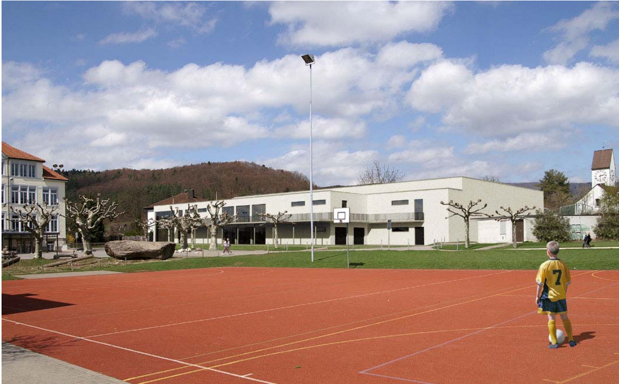
Aussenansicht der sanierten Mehrzweckhalle mit dem Erweiterungsbau (rechts) und der geschlossenen Anlieferung mit Tor (links aussen)
