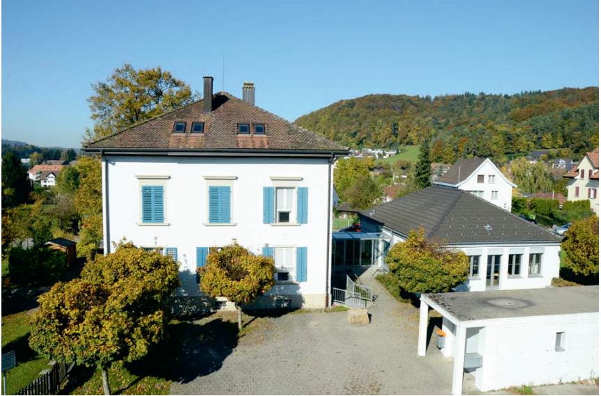
Pfarrhaus (links) mit Annexgebäude (rechts) und Doppelgarage (vorne rechts)
