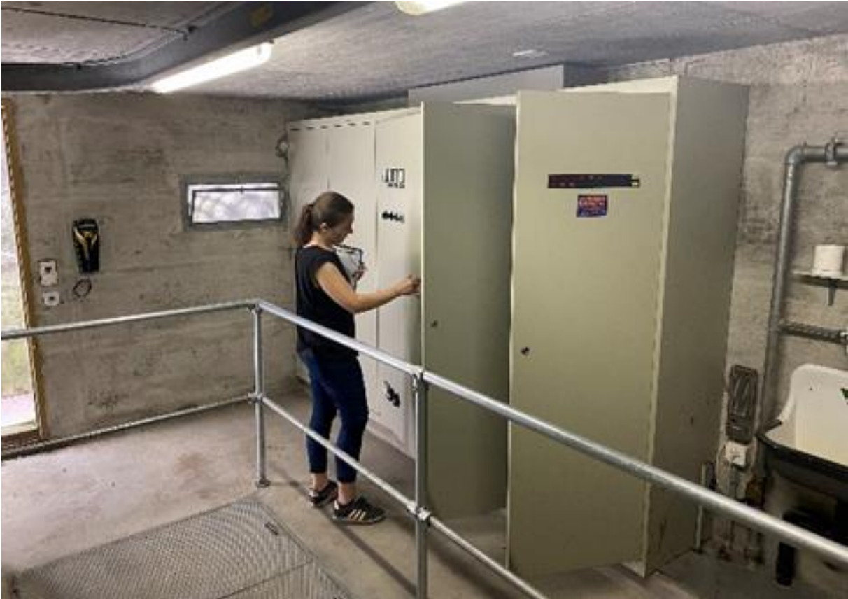
Oben: Nicht mehr vorschriftgemässe Absturzsicherung. Unten: Die über 30-jährige Steuerung und Elektronik muss ersetzt werden.
