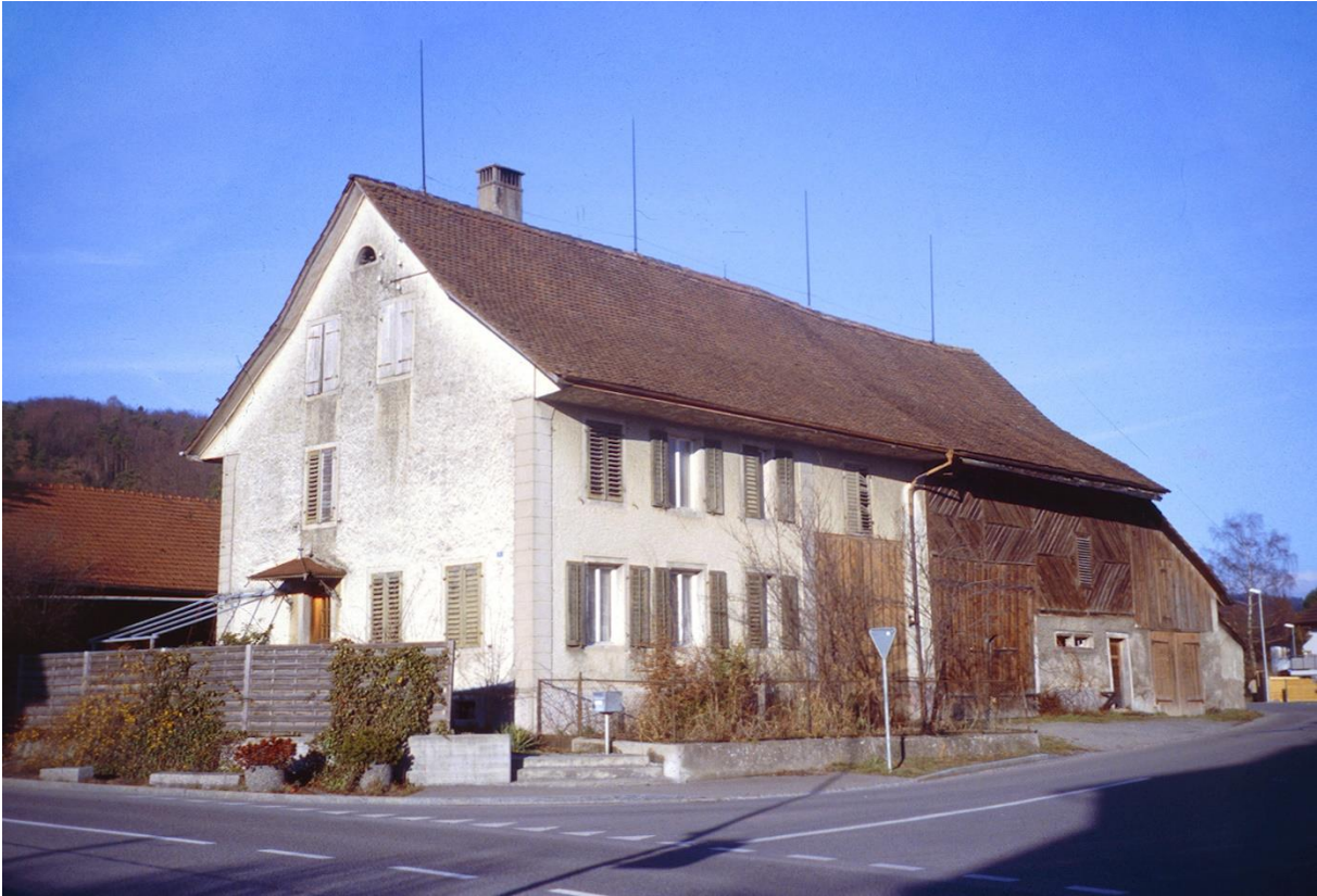
Liegenschaft Landstrasse 53 vor Umbau / Sanierung
