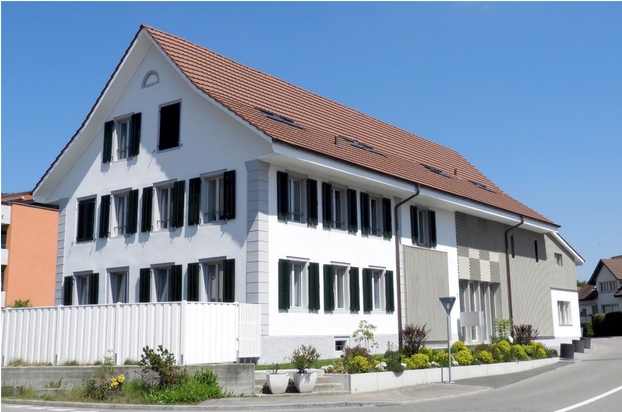
Liegenschaft Dorfstrasse 1 (vormals Landstrasse 53) nach Sanierung
