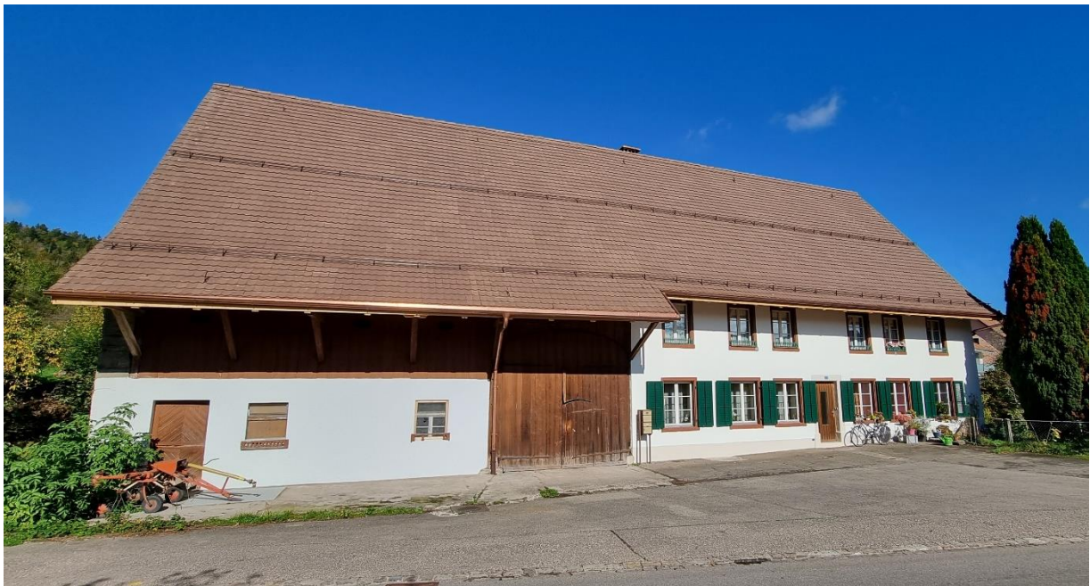
Liegenschaft Dorfstrasse 19 nach der Dachsanierung.
