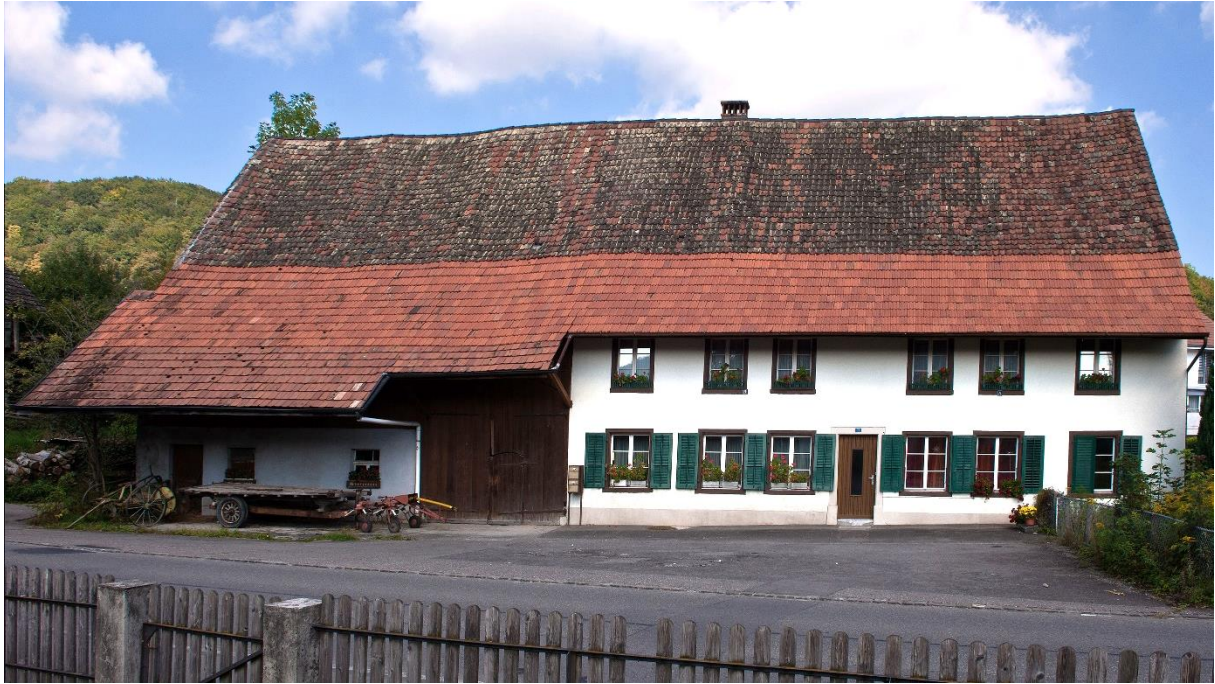
Liegenschaft Dorfstrasse 19 vor der Dachsanierung.
