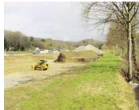
Blick ab der Landstrasse Die Erdarbeiten bereiten den Kiesabbau vor: Der Lugibach wird verlegt. Zuvor erfolgt ein Materialaustausch.
