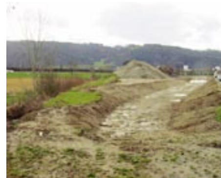
Neues Trassee Lugibach In dieser breiten Mulde wird der Lugibach bald fließen und sich weitgehend selbst vielfältig strukturieren.
