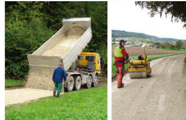
Unterhaltsarbeiten am Waldrand: Nach dem Abladen des Strassenkies wird die Verschleiss-Schicht plattgewalzt und der Weg präsentiert sich wieder in einem guten Zustand. Ordnung muss sein, auch im Wald: Instandhaltungsarbeiten an der Feuerstelle bei der «Gmeumeri»-Hütte.
