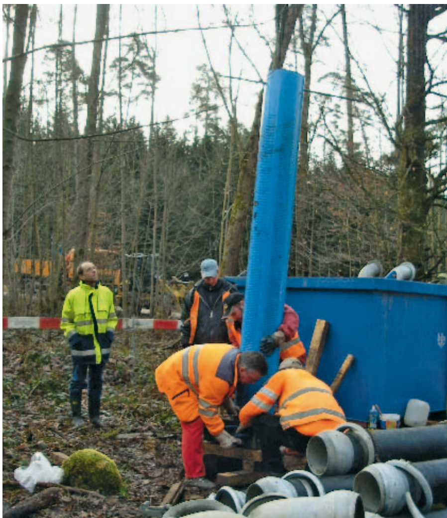
Einbau Filterrohre bei Pumpenbrunnen
