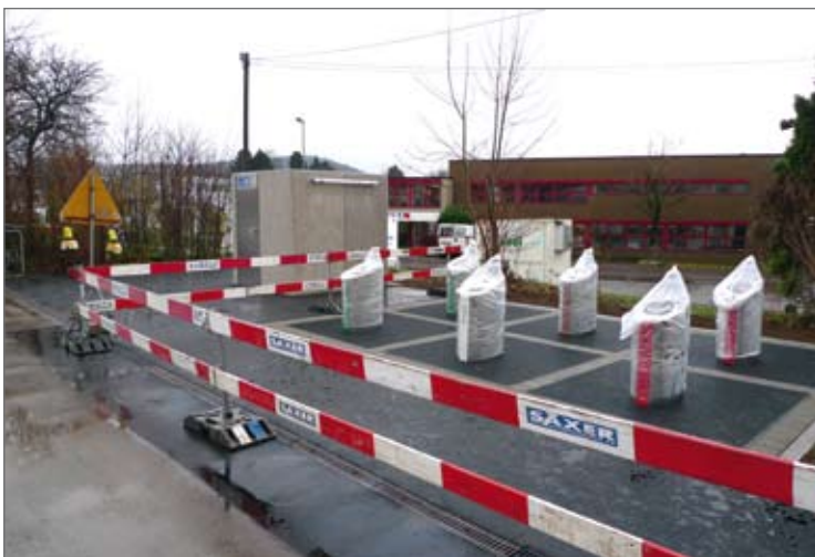
Oben: Beispiel einer Unterflursammelstelle mit Einwurfsäulen
