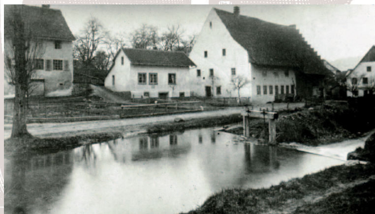
Oben: Der Plan von 1921, auf welchem der Verlauf des Mühlekanals eingezeichnet ist. Unten: Der Furtbach wurde auf der Höhe der Liegenschaft Aeschi (1970 leider abgebrochen) gestaut. Von dort wurde der Mühlekanal abgeleitet (auf dem Bild erkennbar).
