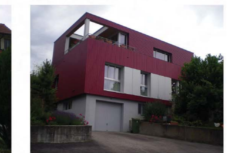
Bild 6: Aufstockung Attikageschoss anstelle Kalt-Estrich
