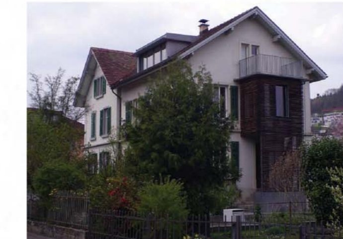
Bild 1 und 2: Ausbau Maisonnette-Wohnung OG-DG
