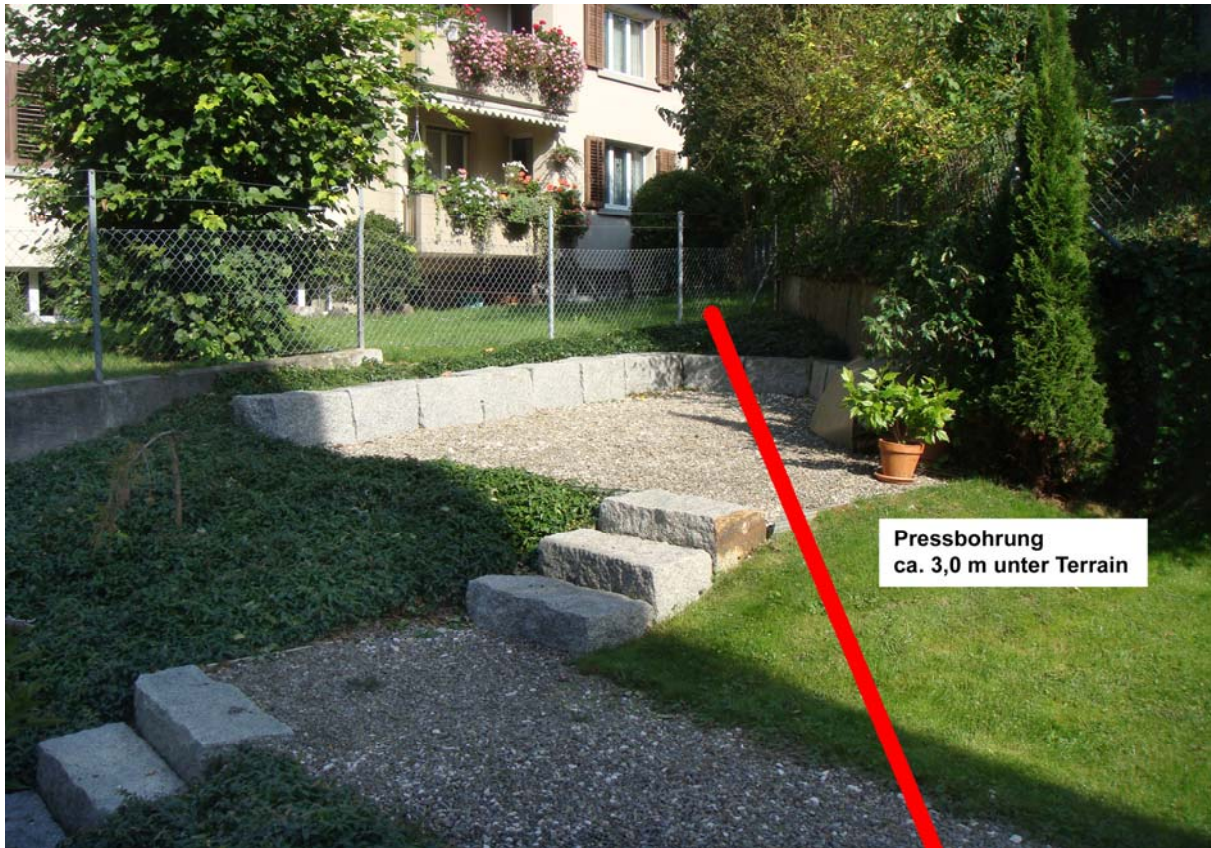
Lage der bestehenden Leitung im Stützmauerbereich
