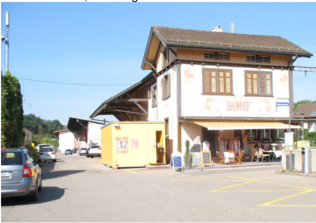
Bahnhofsgebäude, Zufahrt Gewerbe
