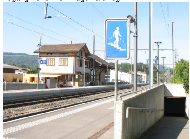
Zugang Rampe Nordseite
