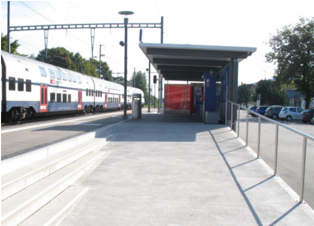
neue Perronanlage, Kundencenter SBB
