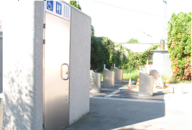
WC Anlage, Abfallsammelstelle
