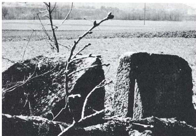
Schwellstock mit Nute zum Einlassen des Schwellbrettes
