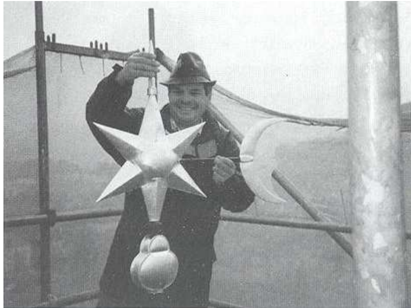
Turmkugel, Kreuz und Wetterfahne in neuem Glanz. Spenglermeister Käufeler setzt der goldenen Pracht die Spitze auf.
