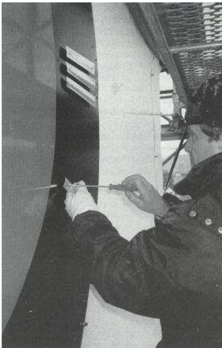
Die zeitlose Zeit ist bald vorüber: An den Zifferblättern der Turmuhr werden die Ziffern montiert.
