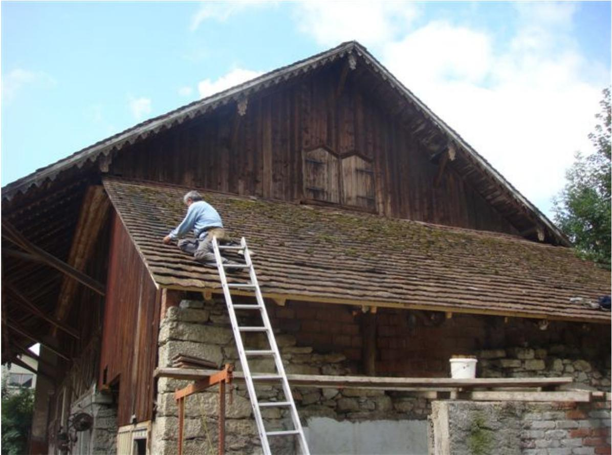
*Reparaturarbeiten an der Zentrumsscheune. Beim Anbau auf der Nord-Ostseite werden die Ziegel gerichtet.*
