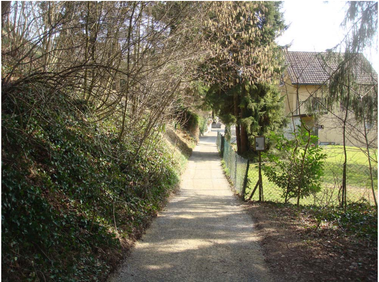
Sanierter Fussweg im "Grimmistal"
