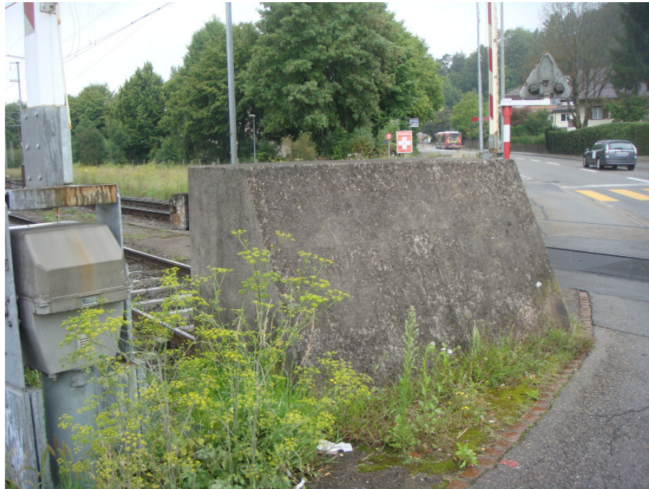
Sichtbehinderung durch den Prellbock beim Bahnübergang (oben). Abbrucharbeiten zur Beseitigung des stark armierten Prellbocks (unten).
