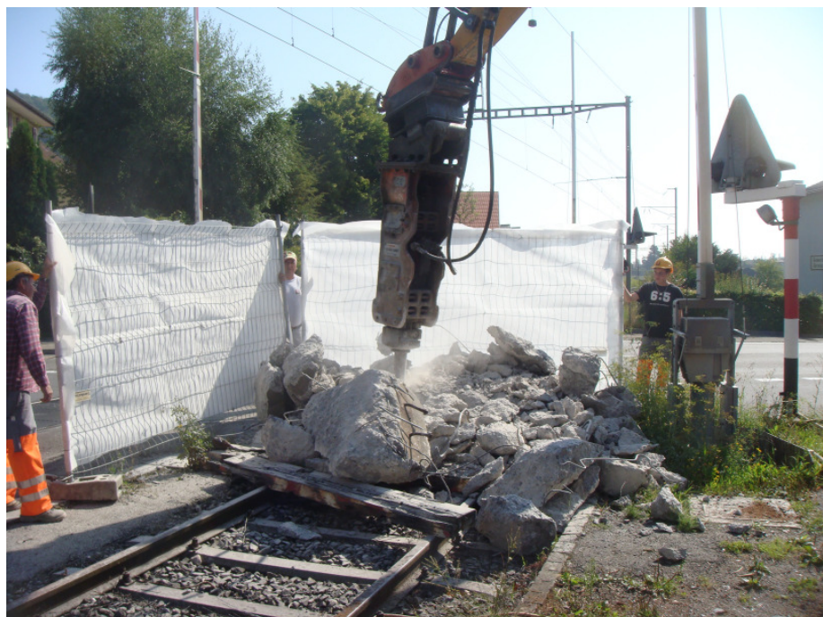
Sichtbehinderung durch den Prellbock beim Bahnübergang (oben). Abbrucharbeiten zur Beseitigung des stark armierten Prellbocks (unten).
