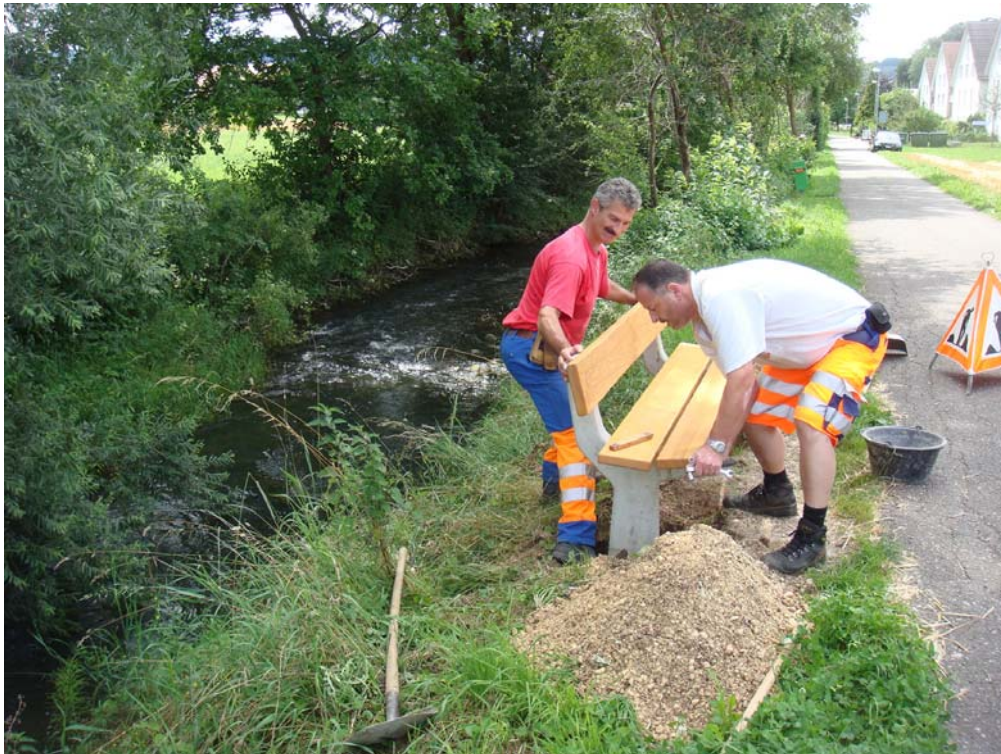
Die Mitarbeitenden des Bauamtes bei der Montage der Sitzbank.
