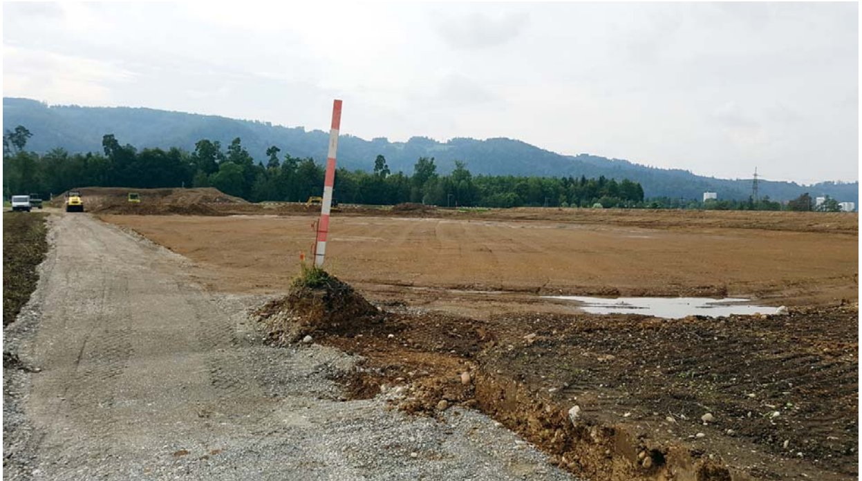
Baustelle für den Sportplatz "Tägerhard"
