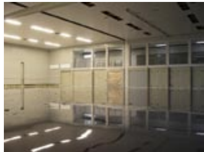
Blick von der neuen Galerie (links) und der noch frische, flüssig eingebrachte Hallenboden (rechts)
