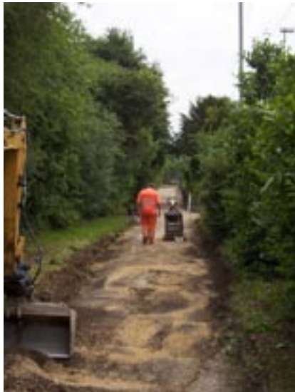
Sanierung Tägerhardweg: Die Planie wird erstellt (links), der Belag ist eingebaut (rechts)
