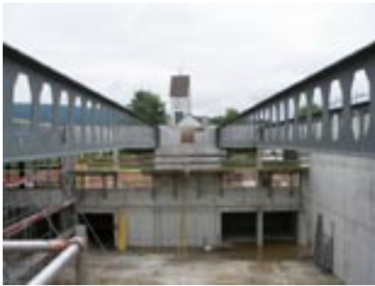
Dachträger und Dreifachhalle (links), neues Obergeschoss mit Galerie und Mehrzweckraum (rechts)
