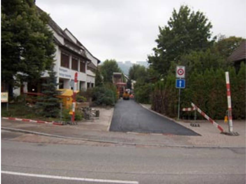
Einbau des neuen Belags auf der Einbahnstrasse beim Café am Bach
