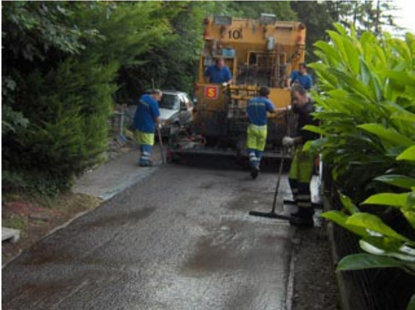
Einbau des Kaltmicrobelags am Taunerwiesenweg
