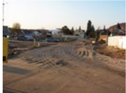
Bickacher: Veränderungen bahnen sich an Mitte August 2008 (links). Nach erfolgter Abhumusierung kommt das weiche Planum hinzu (rechts).
