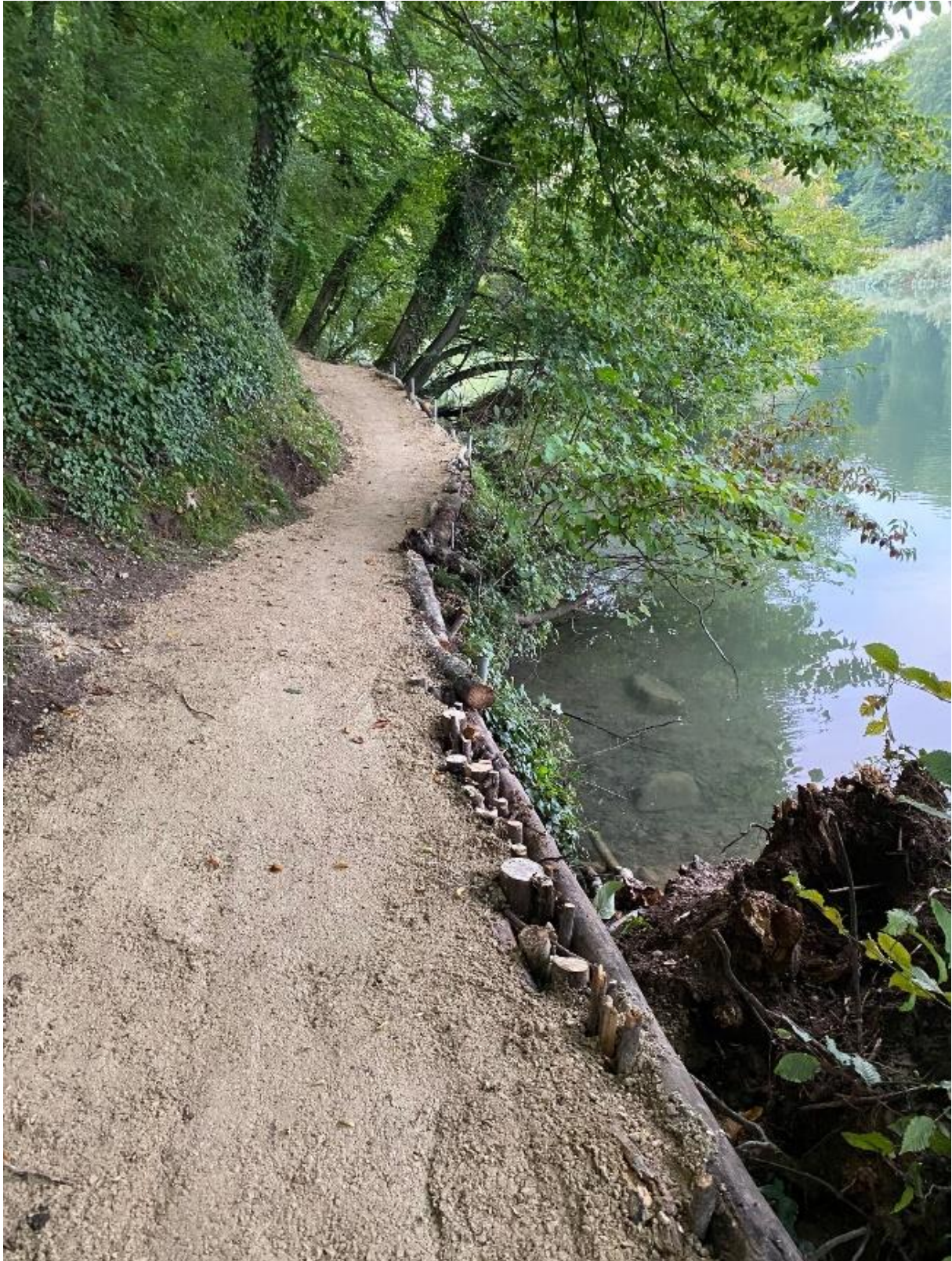
Limmatuferweg nach der Sanierung durch die ZSO Wettingen-Limmattal
