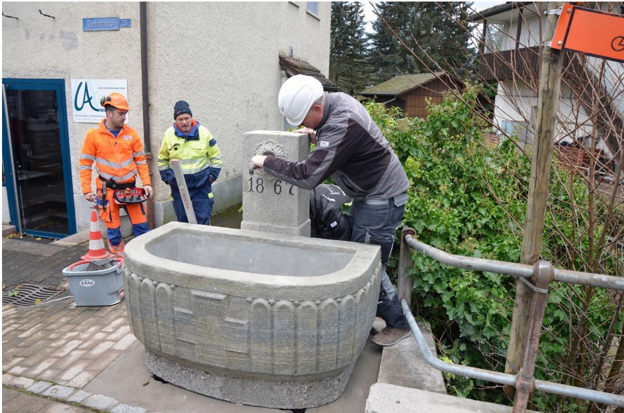
Sanierung des Brunnens von 1867 an der Dorfstrasse bei der Furtbachbrücke
