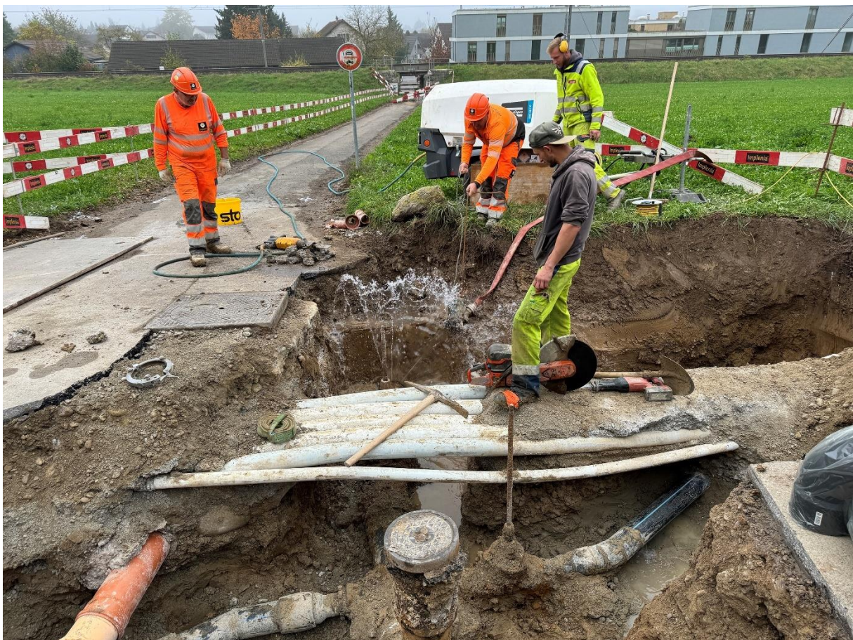
Werkleitungssanierung an der Zelglistrasse
