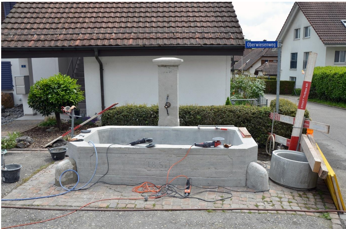
Sanierung des Brunnens von 1857 am Oberwiesenweg im Kempfhof
