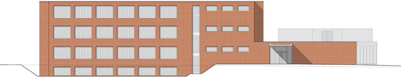
Ansicht Nordwesten Schulhaus
