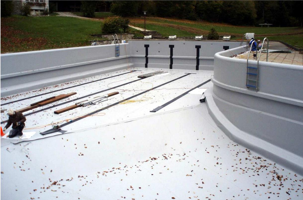
*Beispiel einer Folienauskleidung eines baugleichen Beckens (oben) und Zustand nachher (unten).*
